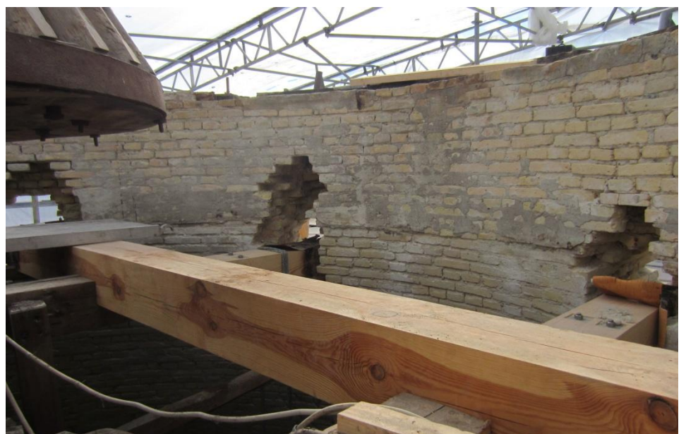
Udskiftning af de bærende bjælker – de nye er Douglasgran.....
