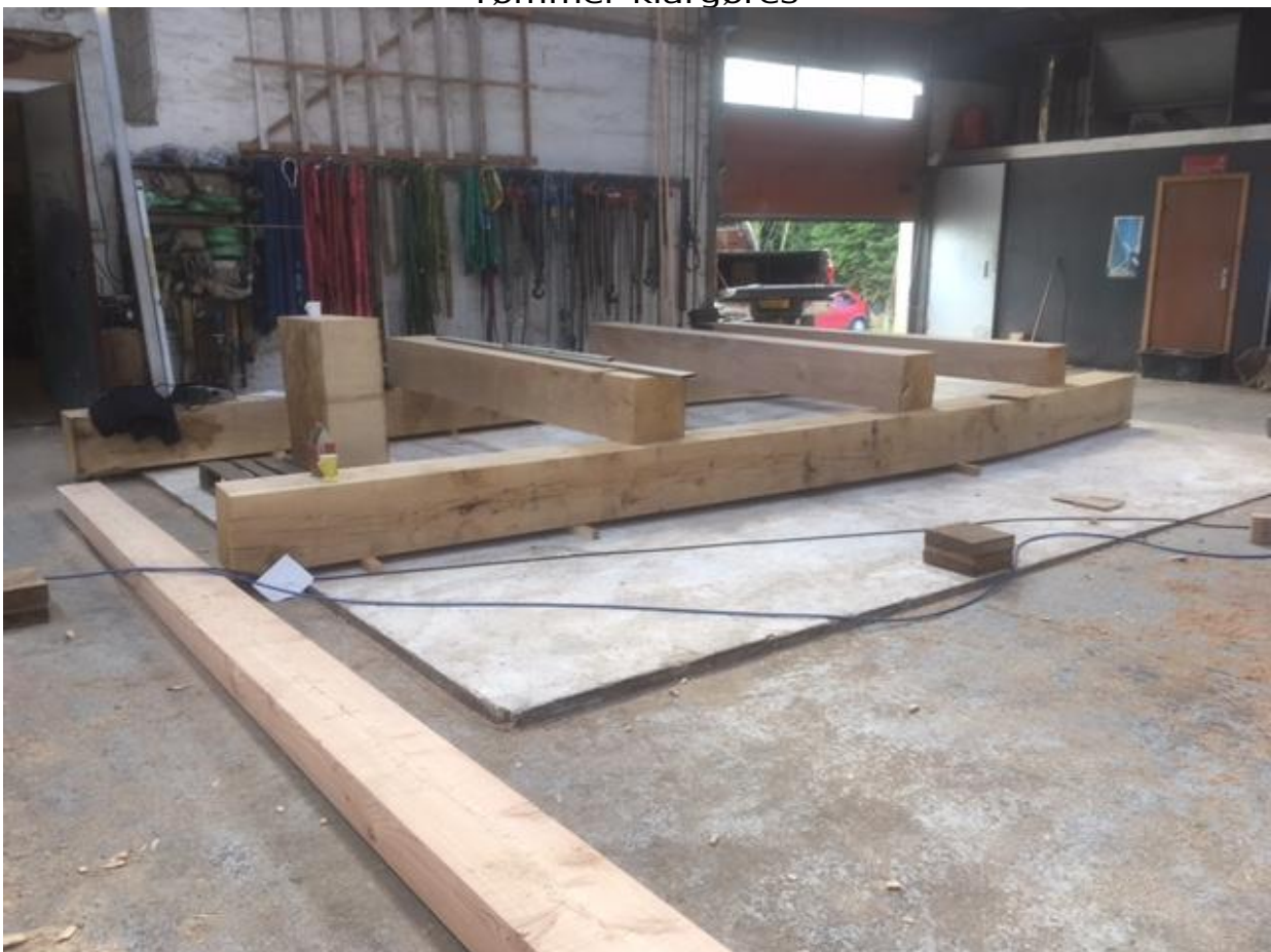
Her er de gået i gang med hattens bærende konstruktion. De to lange krummede i bunden er Saksbjælkerne Det er denne konstruktion der skal bære den lange vingeksel.
