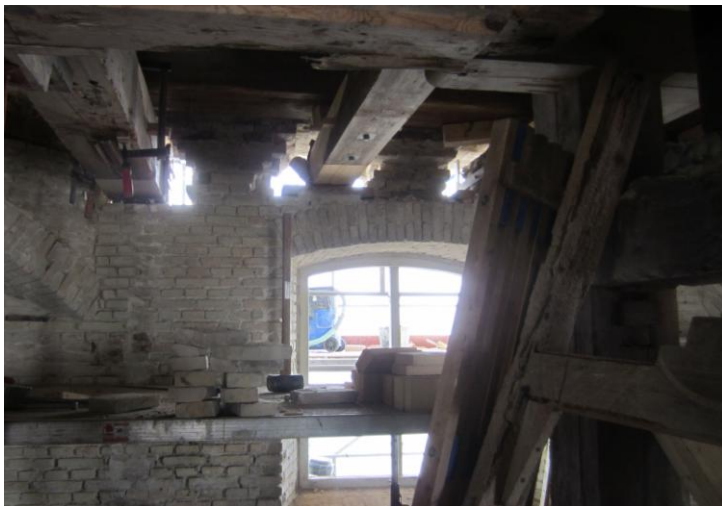
Her står en fransk lus – klar til at blive skubbet gennem hullet udefra . For herefter at blive låst med to kiler – én fra hver side.
