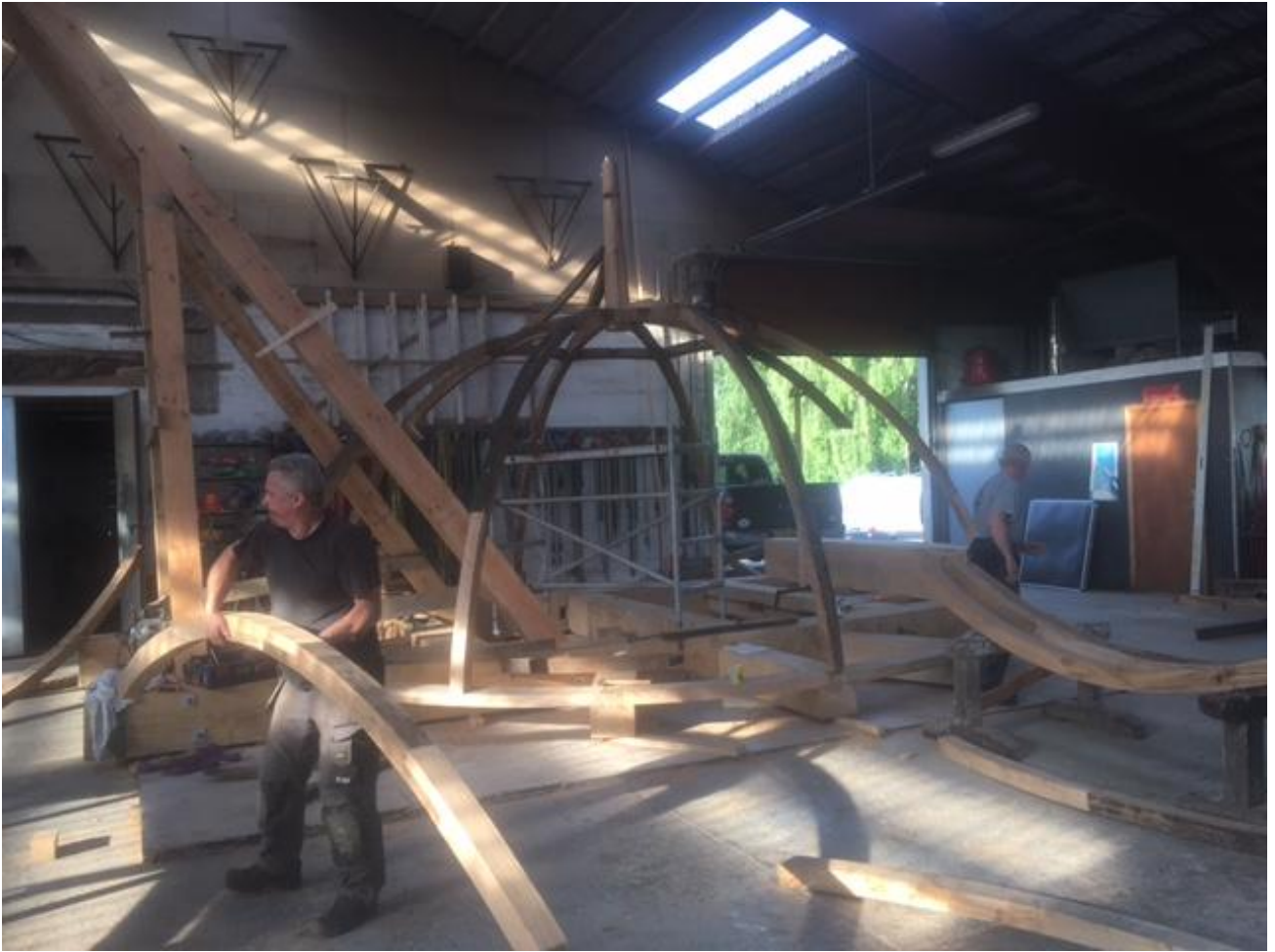
Det ses at de første 8 hovedbuer er rejst
