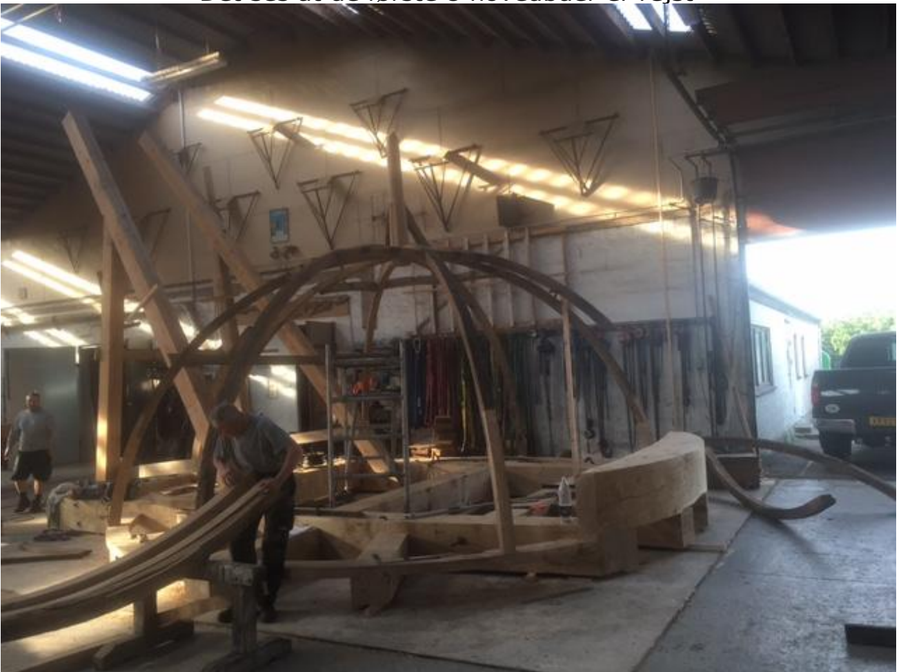
Mellem hver af de 2 spær kommer yderligere 2 spær som dog samles længere ned
