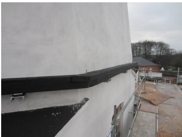
Den bærende rem rundt om møllen er på plads.
