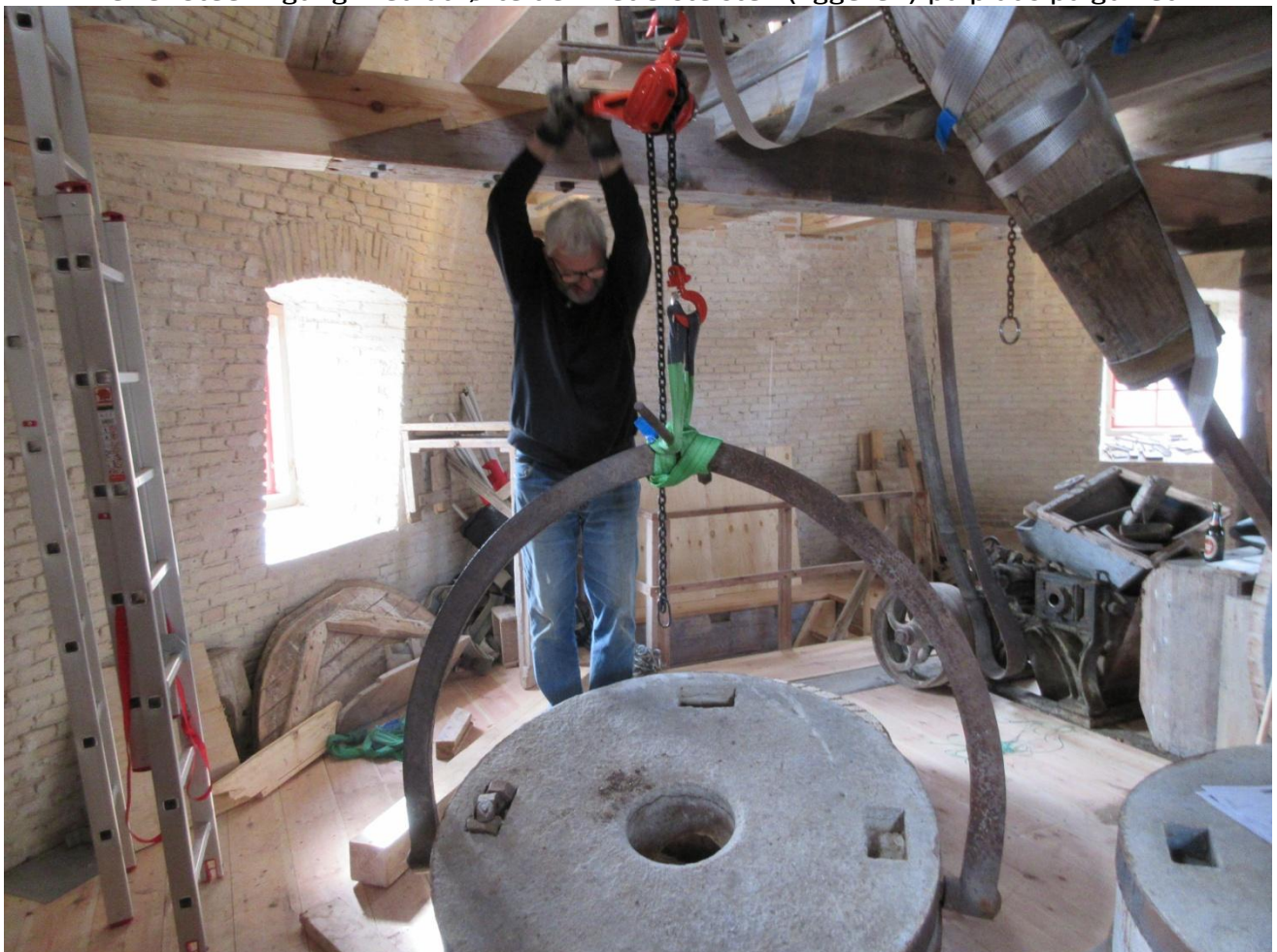
Her er den øverste sten (løberen) på vej op over den nederste som allerede ligger på gulvet
