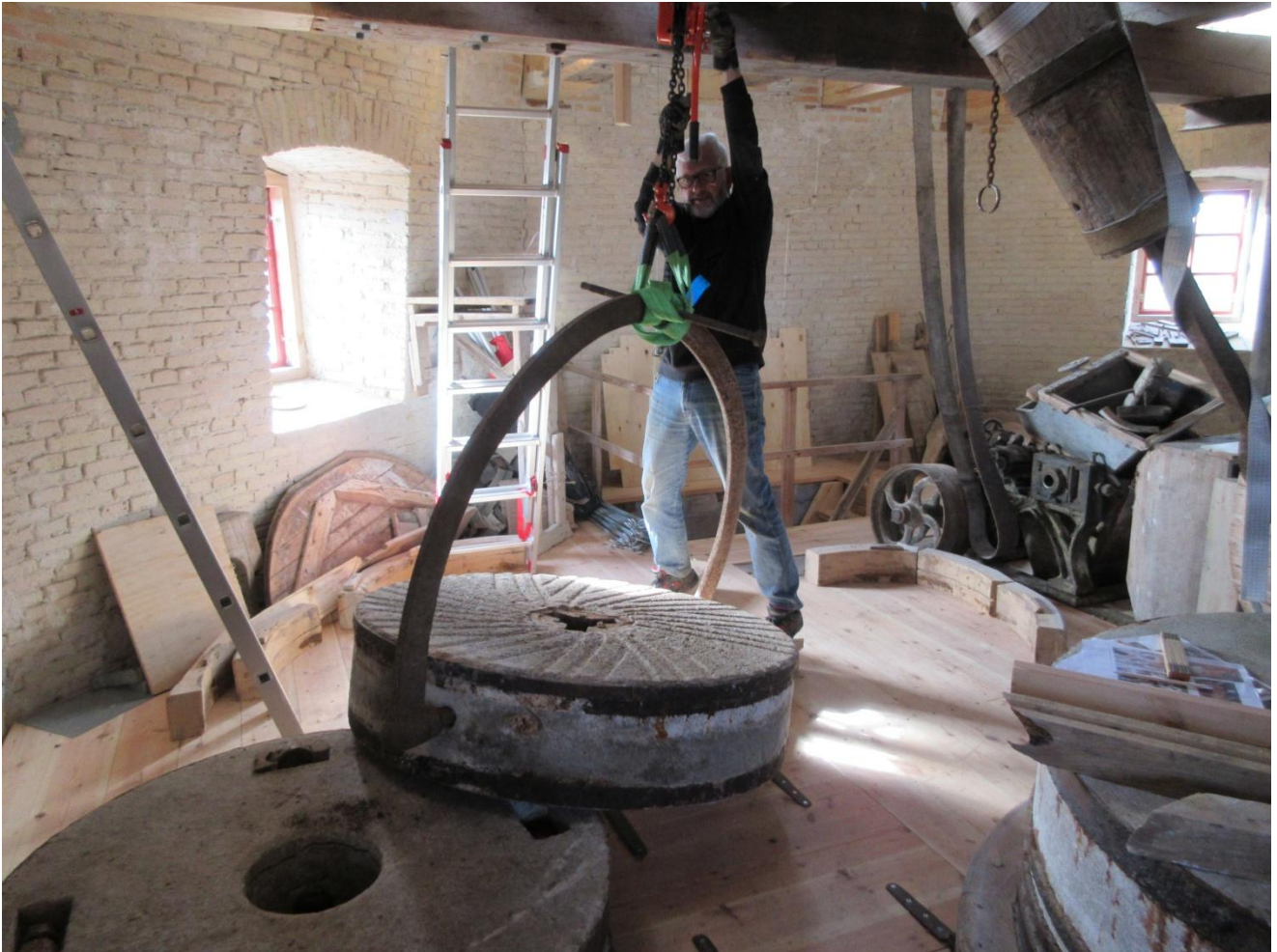
Her er Steen i gang med at løfte den nederste sten (liggeren) på plads på gulvet.
