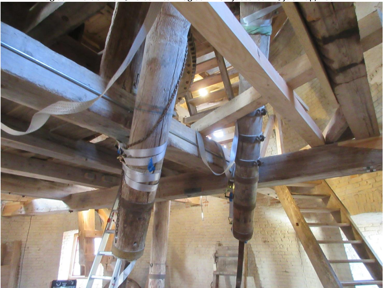
Herefter mangler en af de to spilstokke at blive sænket ned i kværnen og derefter tilsluttes kværndrevet Stjernehjulet.
