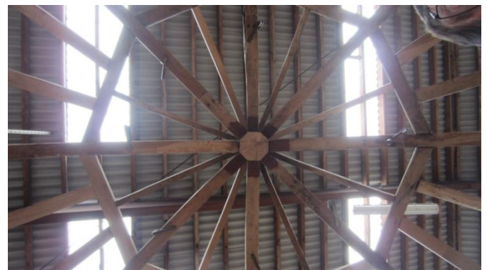
Imponerende at se det gamle håndværk udført i 2017.
