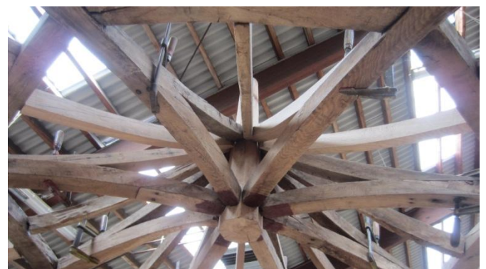
De dele af den gamle hat som kan genbruges bliver det – ellers produceres på stedet nye "reservedele"
