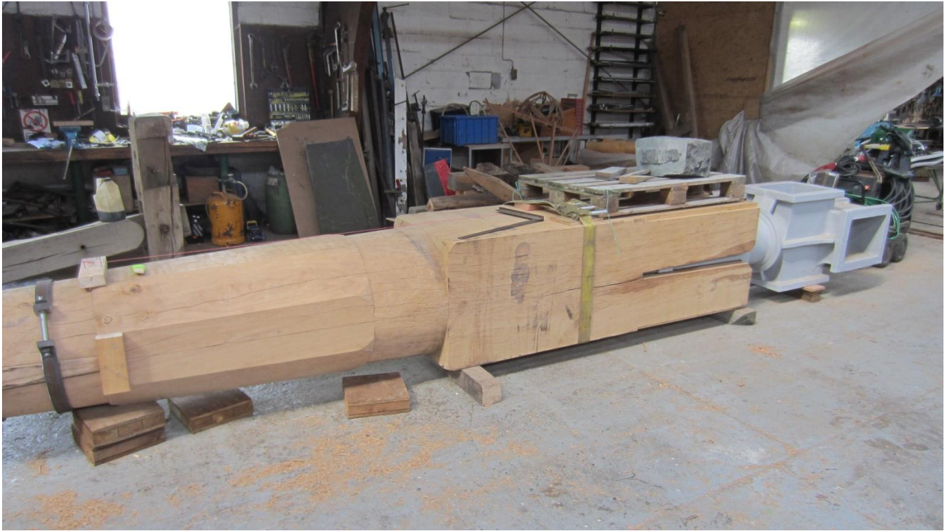
På gulvet ligger den ca. 5-6 meter lange Vingeaksel, som placeres inde i møllehatten og som skal bære de to sæt møllevinger.
