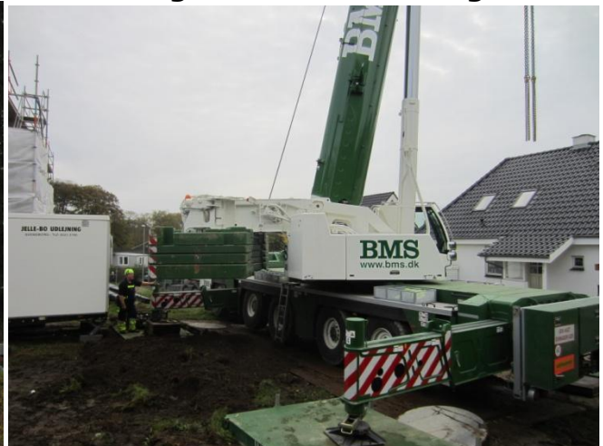
Ud over kran også lastbil med modvægte Alene bag på kranen anbringes 13 t modvægt
