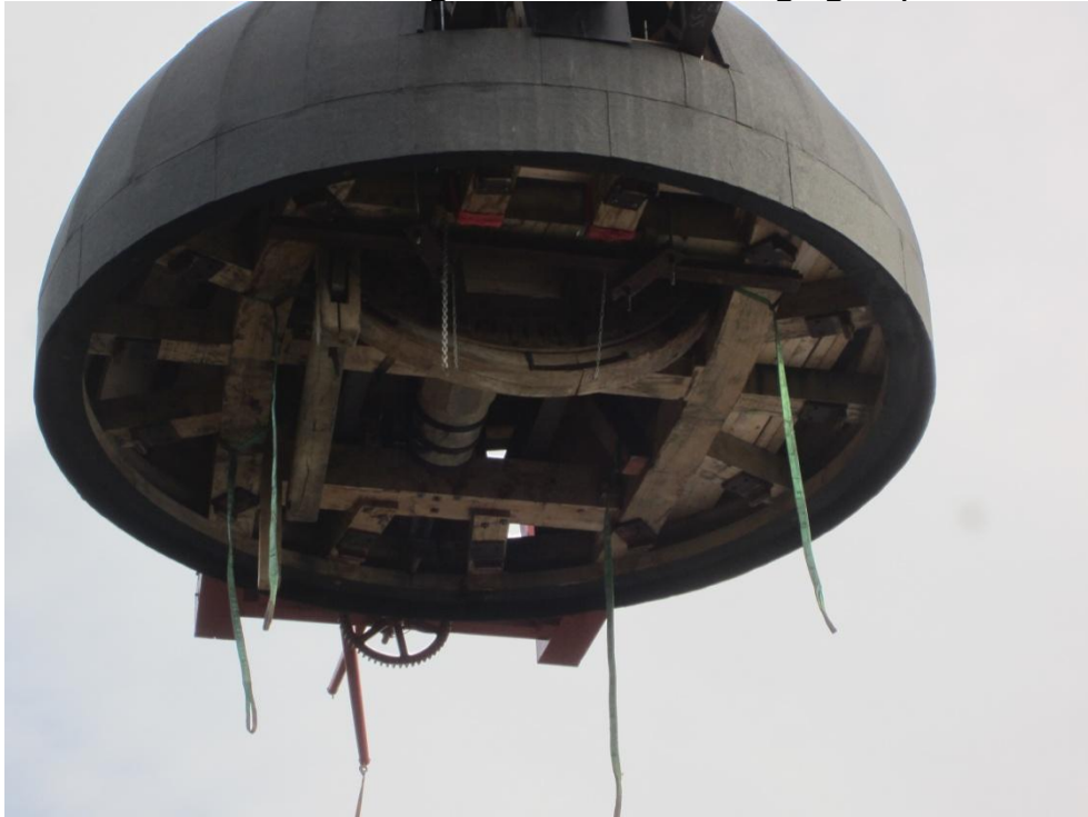
Et kig op under hatten hvor vi aner den lange Vingeaksel og det store Hathjul
