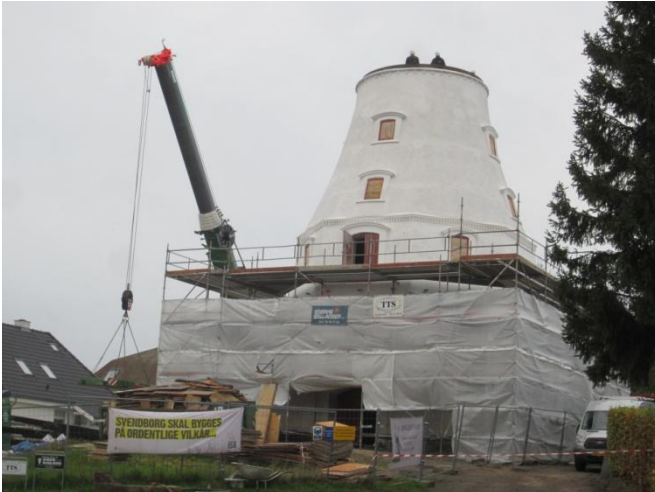
Ud over kran også lastbil med modvægte Alene bag på kranen anbringes 13 t modvægt
