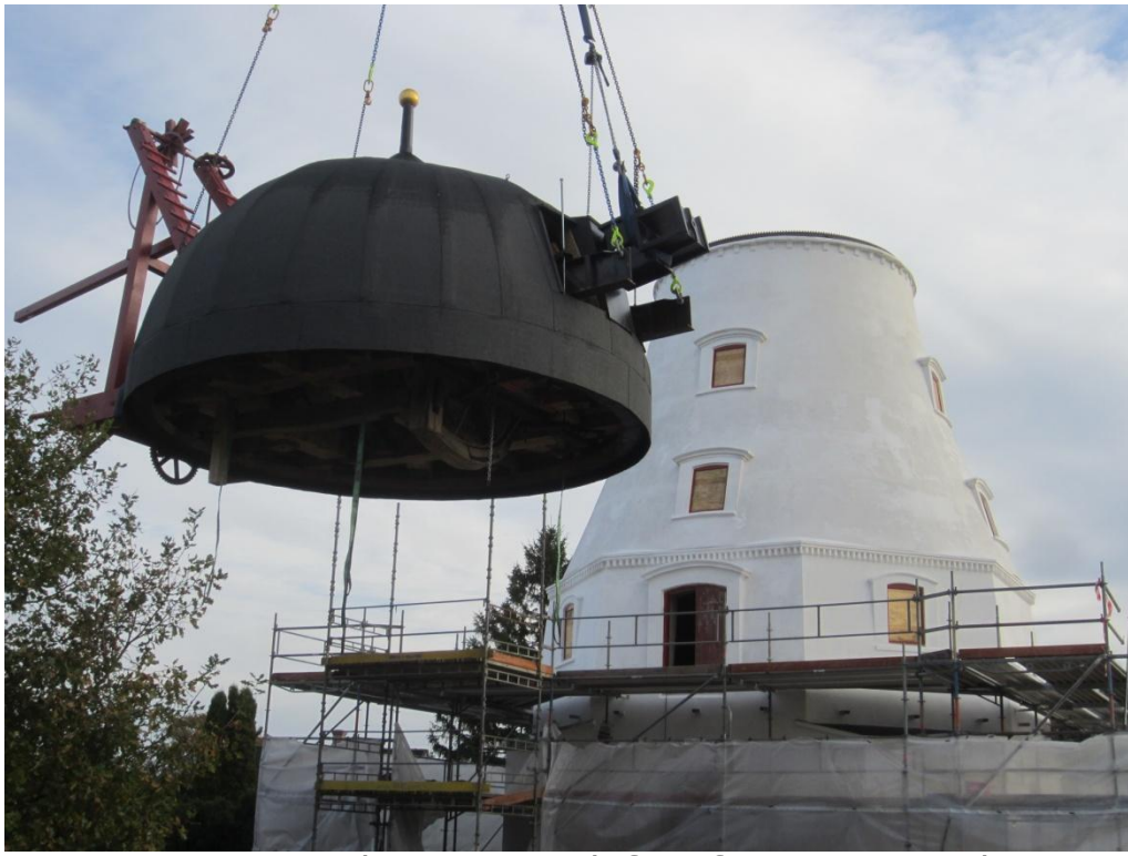
Den 18 tons tunge Hat løftes forsigtigt opad
