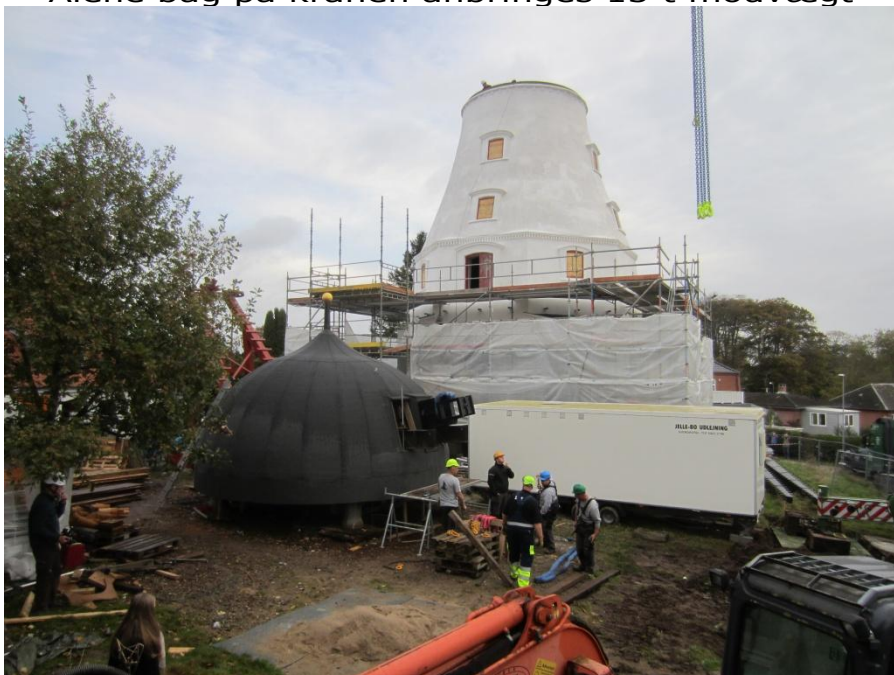
I går blev der anbragt 2 x 3 m løse jernsveller som blev forankret og blev brugt til at løfte Hatten i
