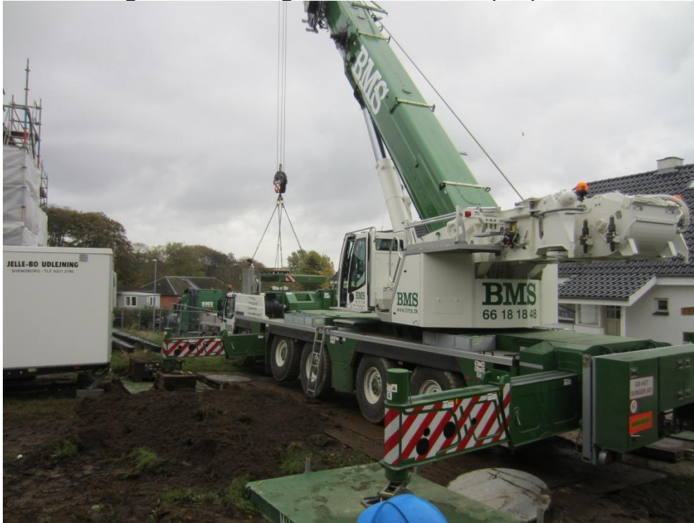
Kl. 8-10 forberedelser af kran med anbringelse af kontra vægt
