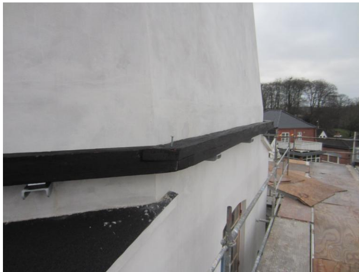
Den bærende rem på Kværnloftet er en regelmæssig ottekant med 8x3 i alt 24 beslag
