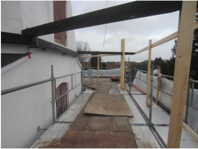
Den bærende rem (træstolper) hele vejen rundt om Kværnloftet (den regelmæssige ottekant) er nu sat op og hviler på 8x3 / 24 beslag.
