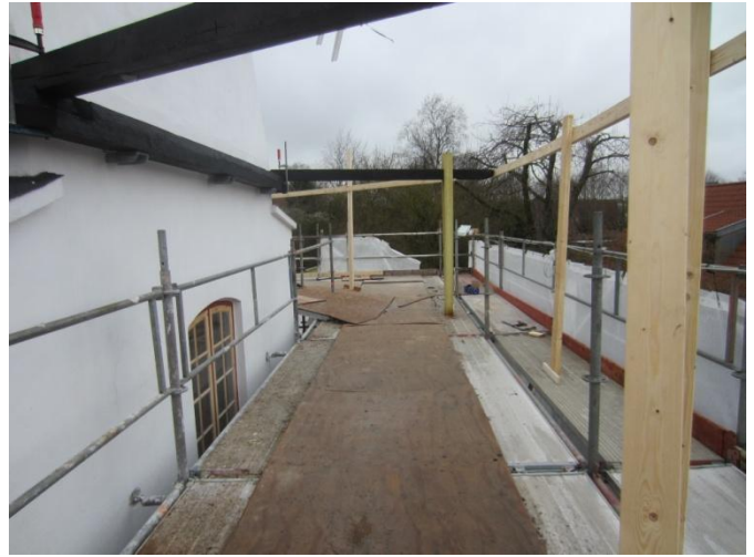
Et stort Puslespil skal passes til. De 8 vandrette bærende remme er nu sat op i hjørnerne. Ind imellem disse skal sættes kortere remme op så der dannes en regelmæssig ottekant.
