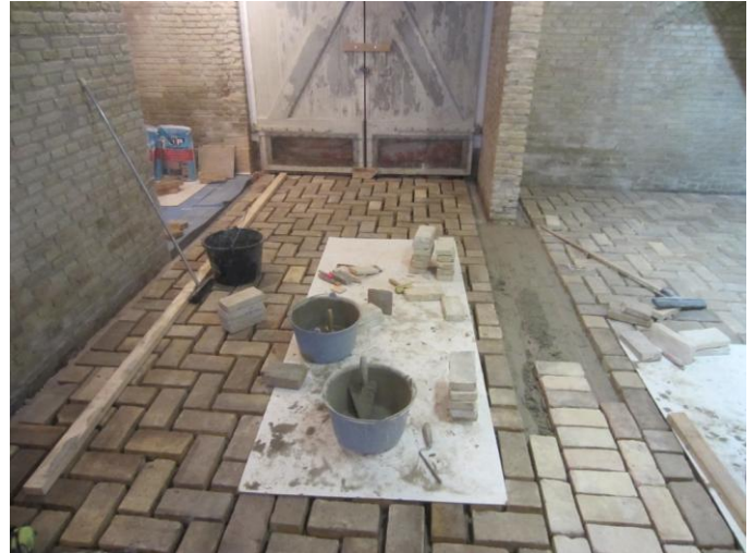
Teglene er håndlavede og derfor svinger de forskellige mål ret meget
