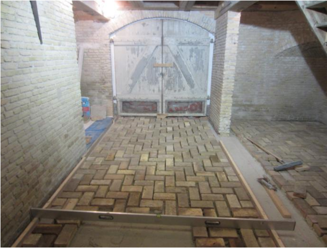
Hele ugen er der blevet lagt tegl på gulvet i Portrummet
