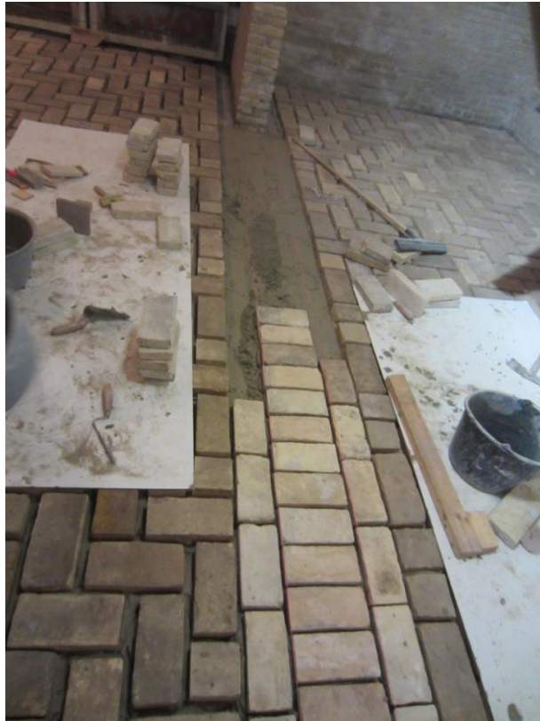
Teglene er håndlavede og derfor svinger de forskellige mål ret meget
