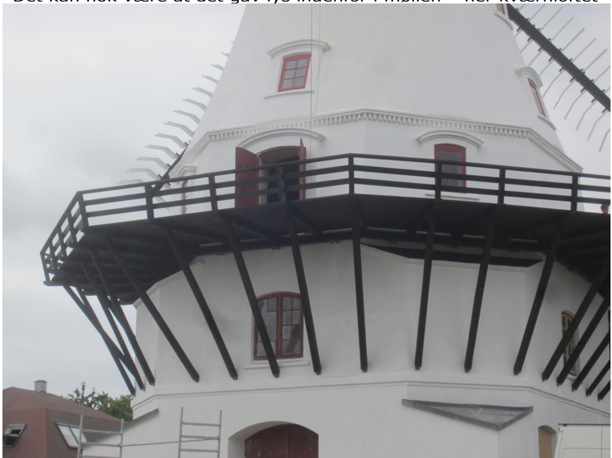
Over Svikstillingen sidder vinduerne alle med 4 hasper og de kan ikke åbnes da vingerne ellers vil slå dem af. . I stedet tager man vinduet helt af, trækker det gennem vindueshullet og sætter det på gulvet indenfor.
