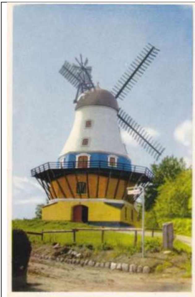
Christiansmøllen Svendborg. Foto nr.19. Møllen monteret med sejlførende vinger. Vindrosen, var på tidspunktet for fotografiets optagelse, under reparation.
