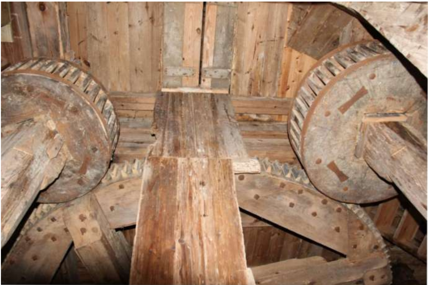
Christiansmøllen Svendborg. Foto nr. 25 & 26. Eksisterende forhold fra henholdsvis kværneloft og stjernehjulsløft.
