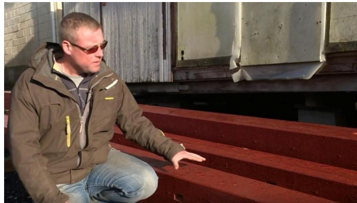
Alle delene prøvesamles og alt checkes. Herefter skilles delene ad igen og Vingearmene, alle klapperne, stokke m.m. males hvidt/ rødt efter ønske.
