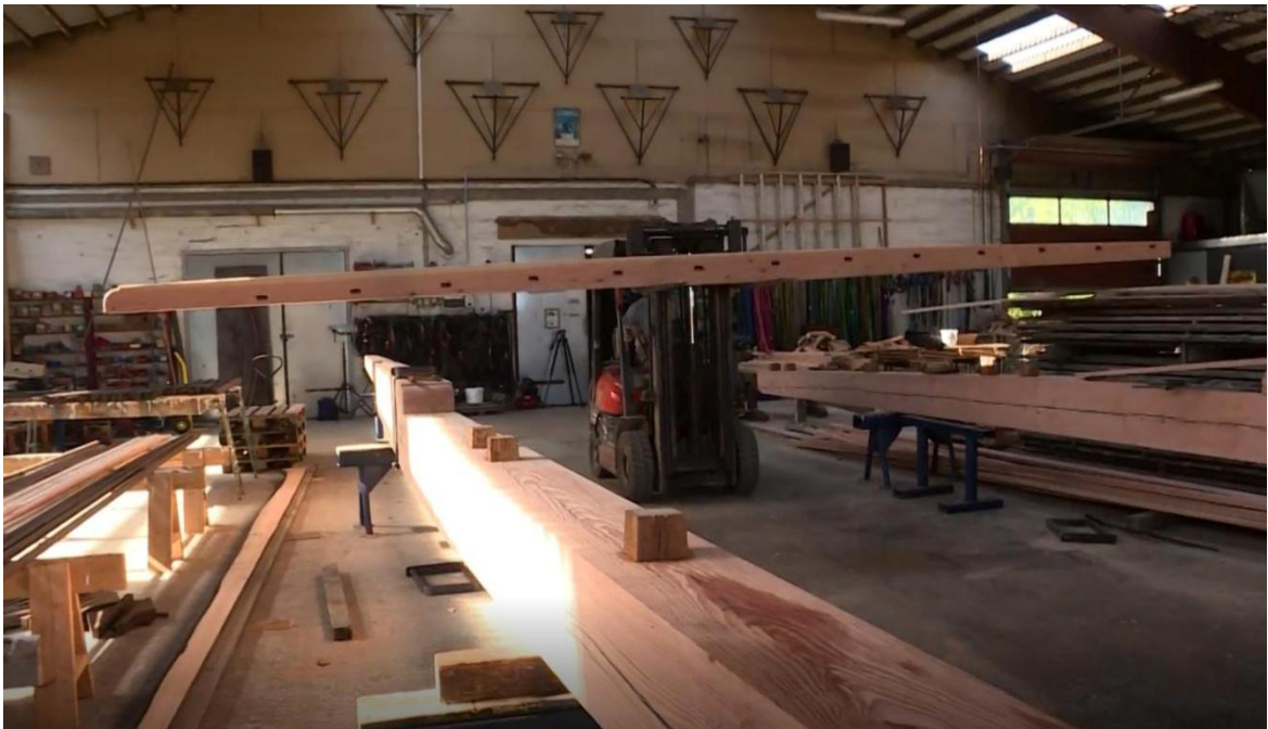
Her kommer Trucken med den første vinge som placeres oven på Hovedstykket. Bemærk 3 Brosten På dette billede er den anden vinge i baggrunden allerede blevet monteret
