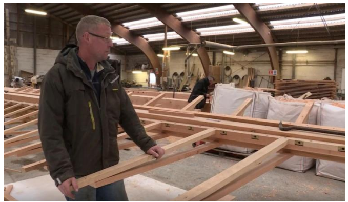
På den anden side hvor de lange stokkeender kommer ud monteres en overligger for at gøre den stærk nok til de store klapper.
