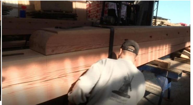
Der spændes 2 kraftige spændebånd/jernbånd rundt om hver Hovedstykke/Vinge
