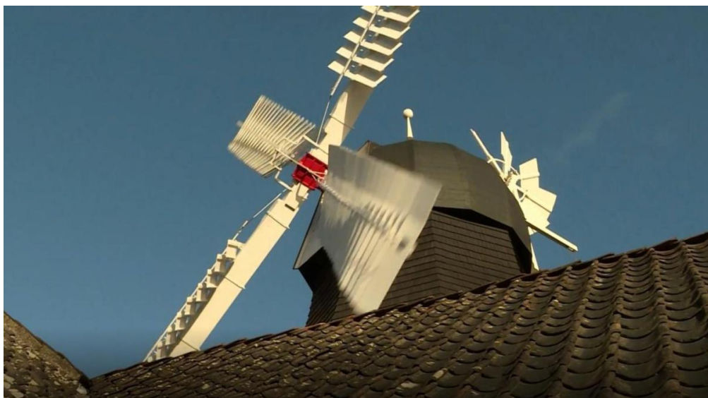
Bemærk at de to modstående ender med klapper på en gennemgående vinge er spejlvendt i forhold til klappernes placering.
