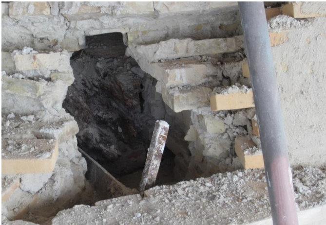
De rådne tømmerender fjernes. Det gamle tømmer forlænges med "fransk lås". (herunder)
