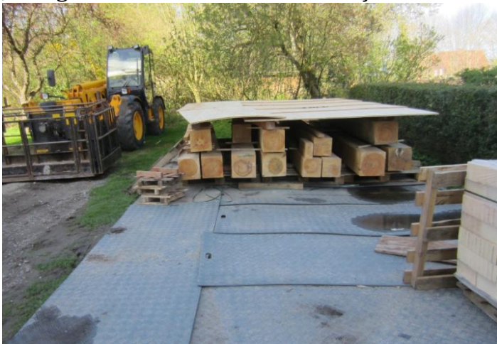
"Pommersk fyr" til udskiftning af tømmer
