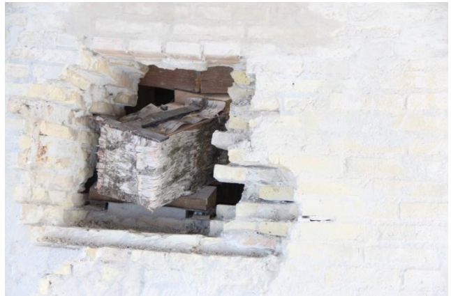
Til sidst beklædes alle tømmerender som skal indmures med Birkebark.
