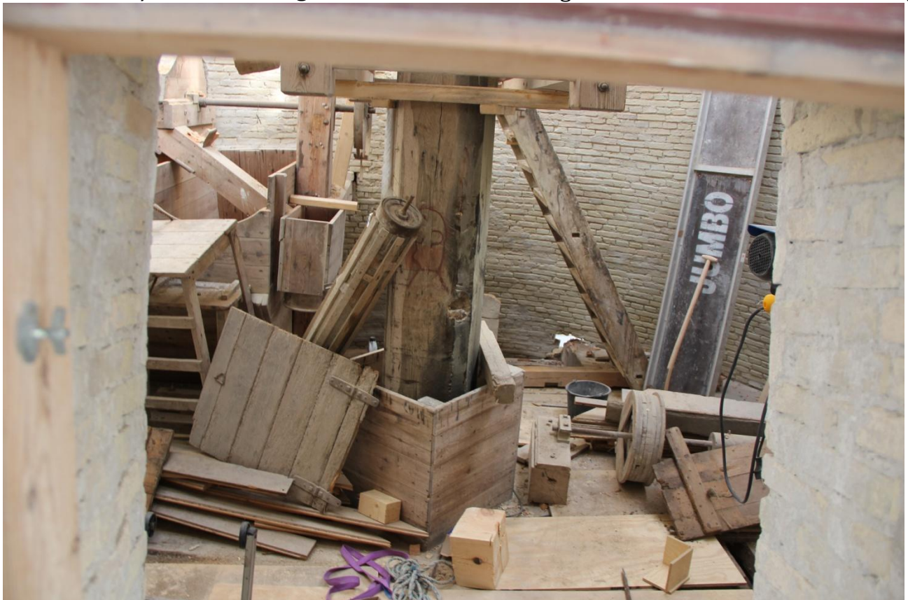
På Lorrisloftet hvor dele til hejsen ses. Der arbejdes på hatloftet lige over.
