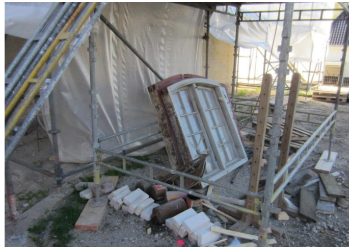
De to gamle vinduer som skal indsættes igen
