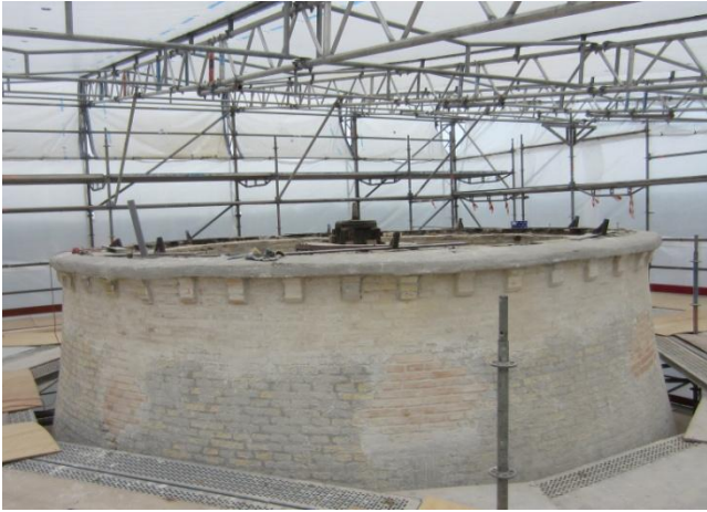
Helt oppe hvor møllehatten skal lægges på er man færdige med det udvendige murværk
