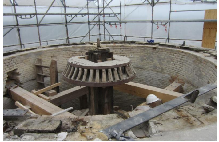
Der arbejdes med det allersidste murværk og isætning af de 4 store remme som skal ligge der.
