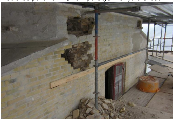
Udvendigt er man gået i gang med Kværnloftet
