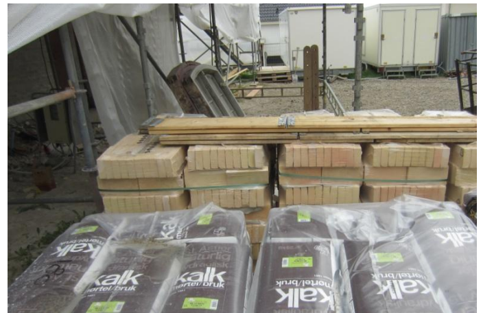
Og masser af de smalle flensborgsten som møllen er bygget med samt kalkmørtel
