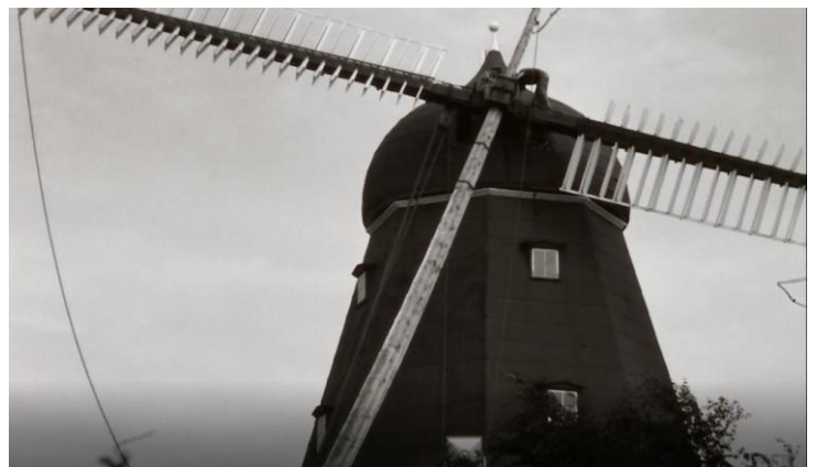
Her er der allerede kommet stokke og monteret klapper på den første dobbelte vinge – Den anden er ved at blive hejst op og er kommet gennem øjet
