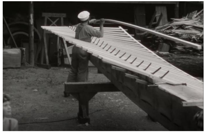
På hver vinge forberedes de selvlukkende klapper
