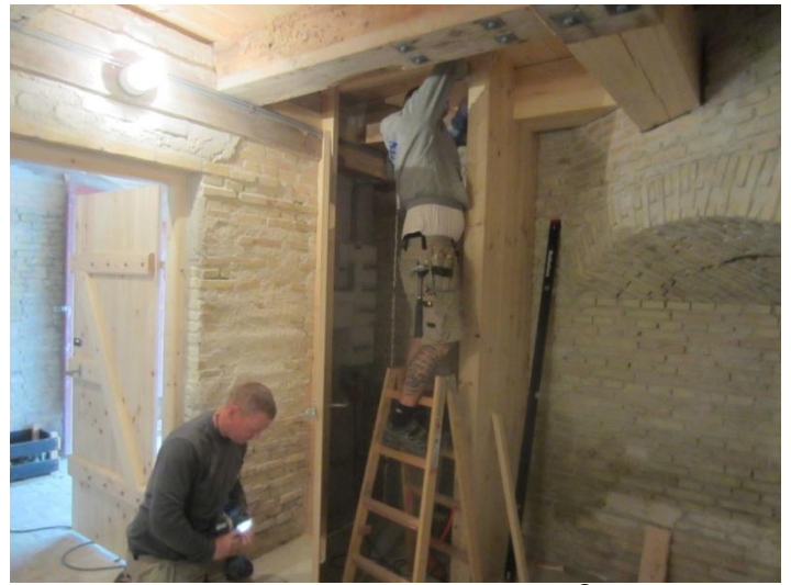
El- og depotskab etableres på toilettet
