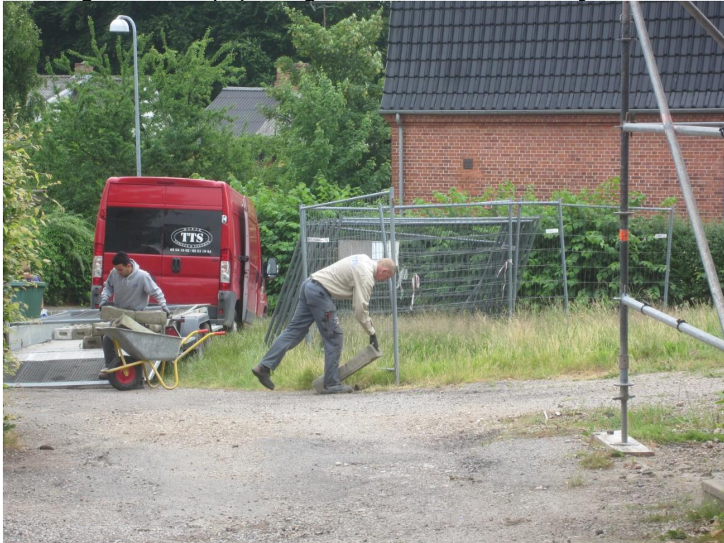
I denne uge er TTS i gang med at rydde byggepladsen.
