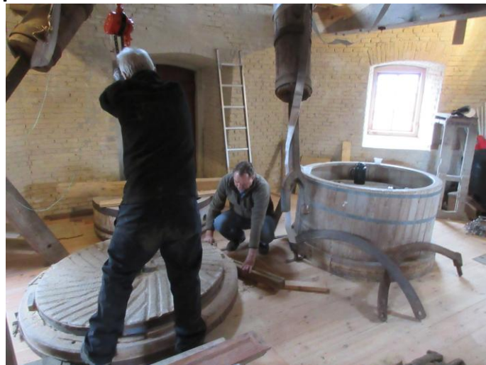
På denne kværn sidder bundrem og nederste kværnsten sammen og løftes samtidig. Stenen alene vejer kun 500 kg.
