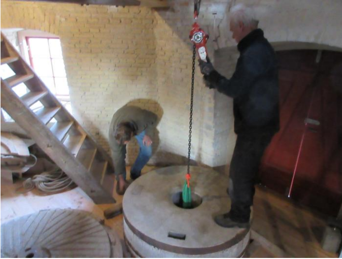
Det kræver 2 flyt med hejs før den er løftet på plads
