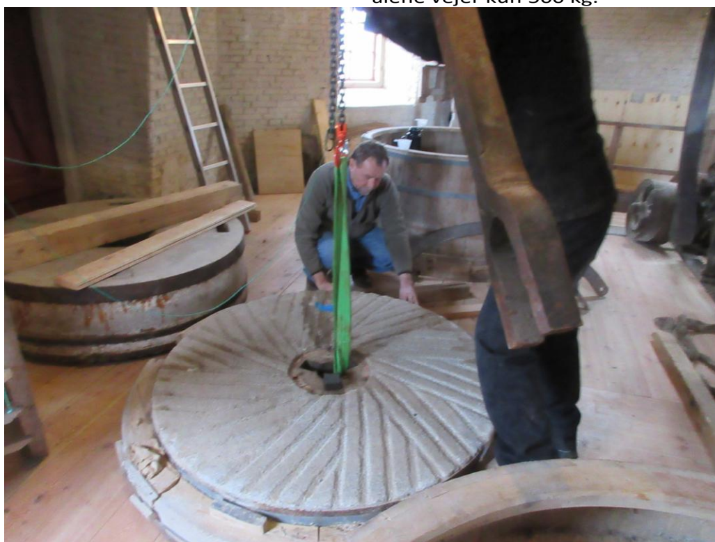
Det tog sin tid at få placeret bundrem og "Ligger" den på den helt rigtige placering.
