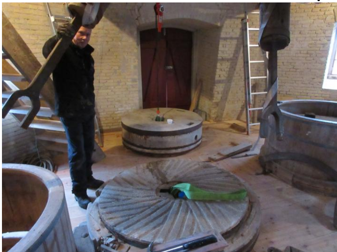
Den øverste sten på 1 ton er løftet hen foran porten
