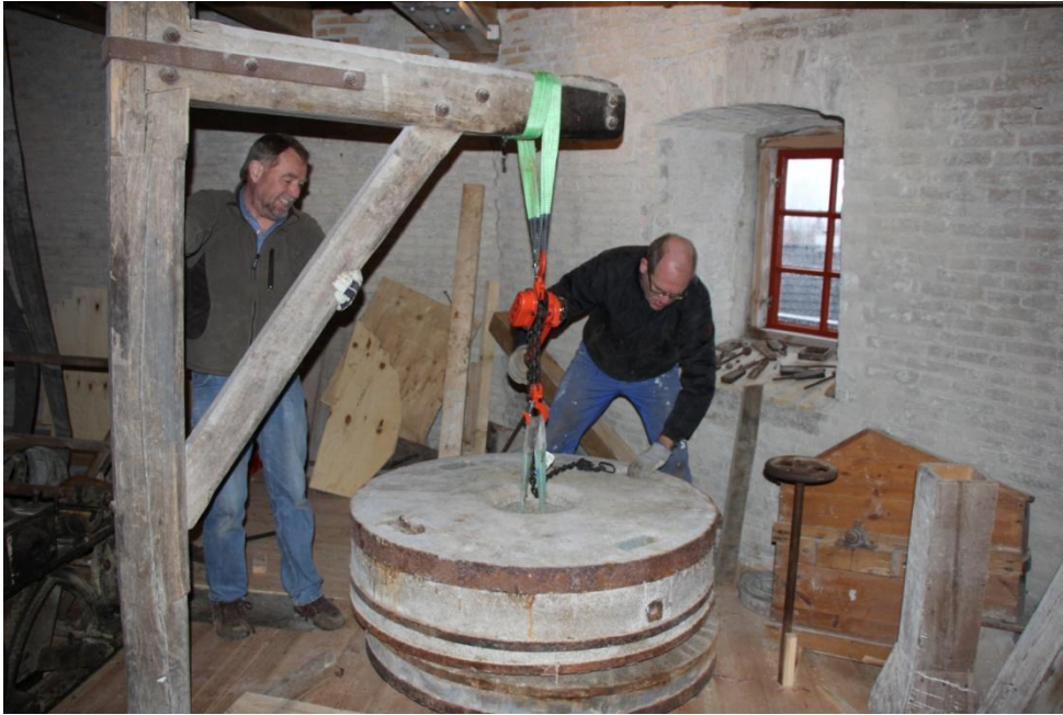
Hvorefter den store sten placeres oven på denne
