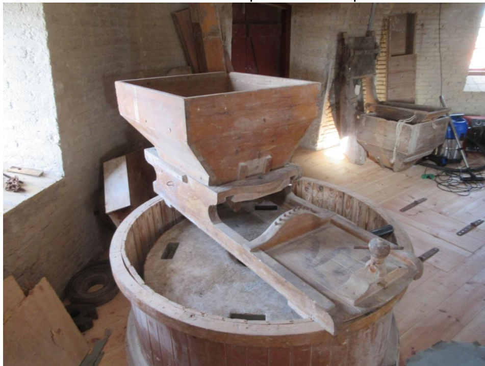
Den nederste del af træ samles. Og kassen mm løftes på.
