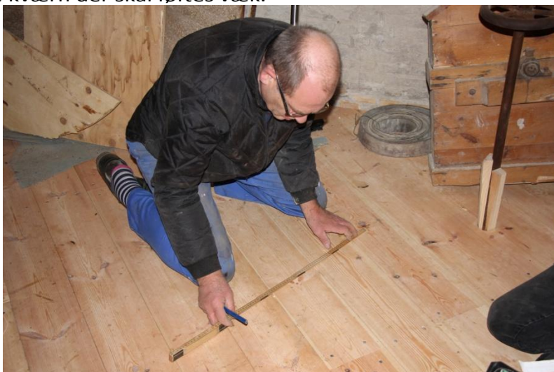
Per har nede på Broloftet målt sig frem til nøjagtig til hvor kværnen har stået før og Hvor de tre støttepunkter skal placeres.
