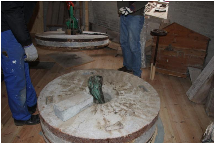
Så er det den øverste kværn der skal løftes væk.
