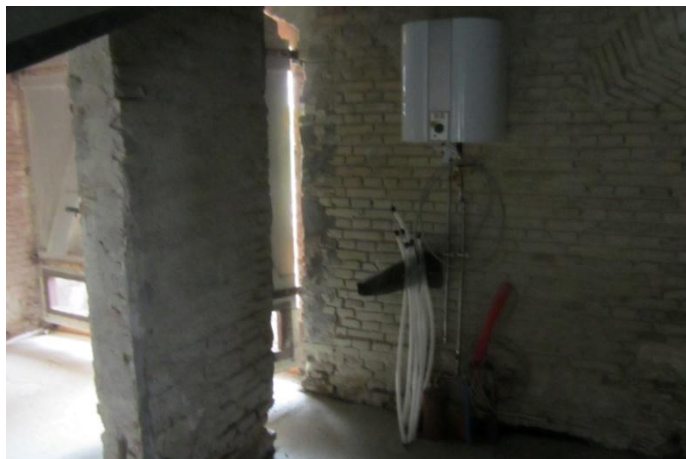
Nederst i Portrummet er nu støbt gulv. Bemærk de blændede vindueshuller, som nu er åbnet. Sikke en masse lys.
