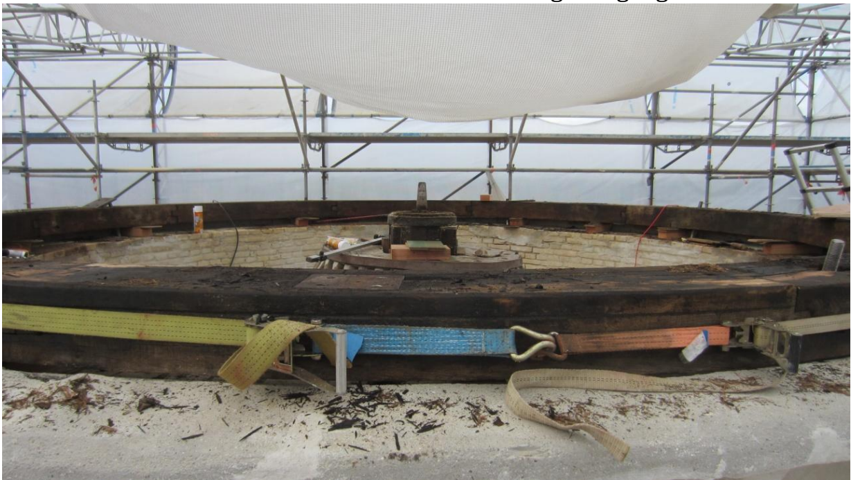
Nu er de halvrunde svellestykker fra den gamle mølletop lagt øverst på kanten og skal nu boltes fast ned i møllens kant.
