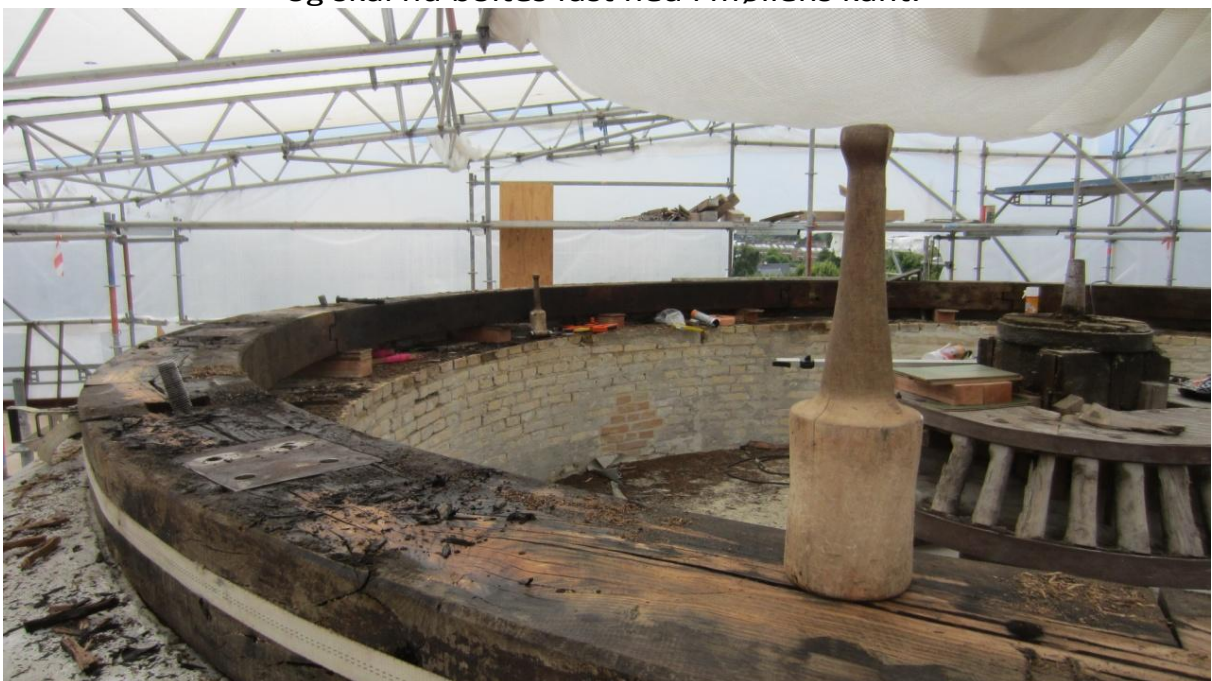
En stor selestrop holder midlertidig fat i alle stykkerne, som passer sammen som et puslespil
