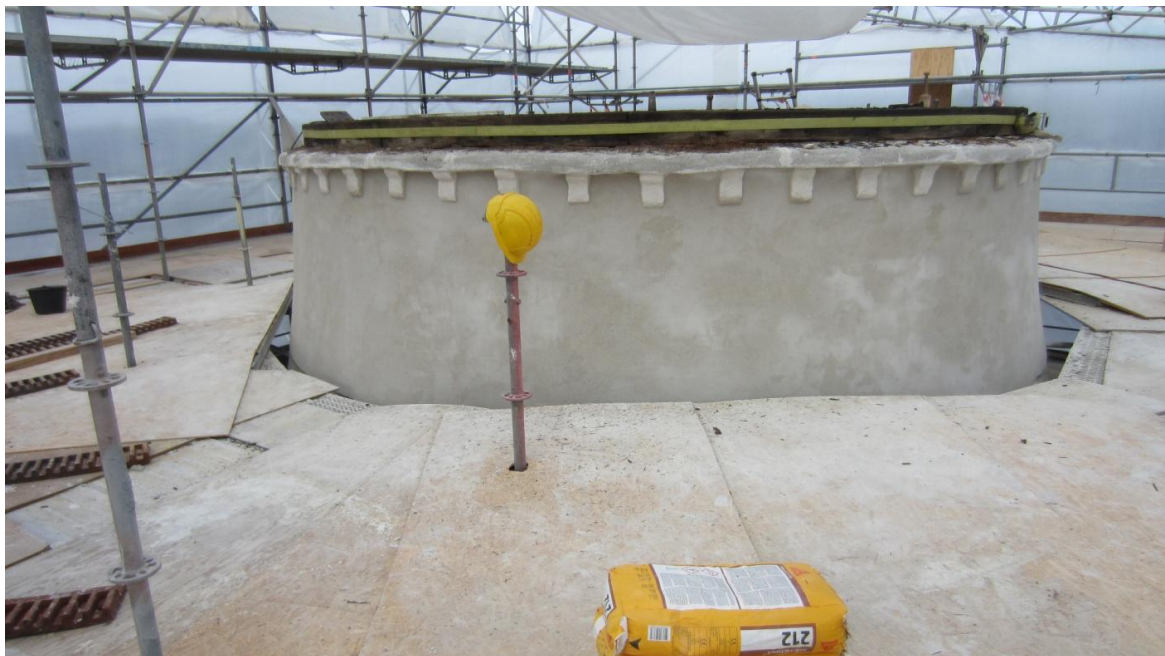
15/8 Overmøllens øverste del er nu finpudset helt færdigt.
