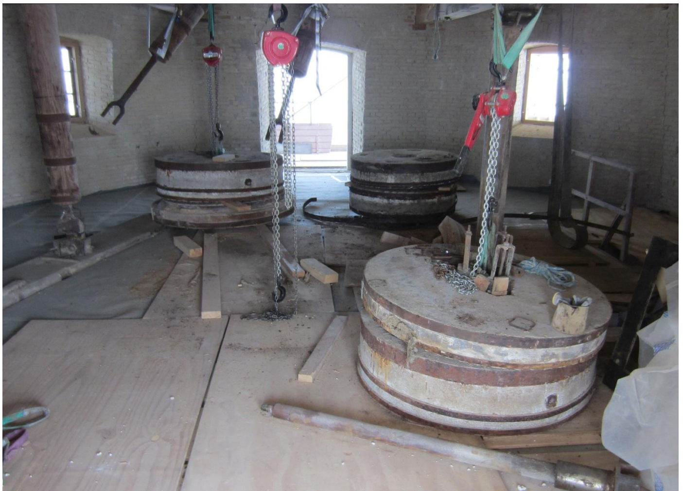
Et kig ind i Kværnloftet hvor det nye gulv er lagt og er dækket godt til. Endnu mangler at stille de 4 kværne de rigtige steder i rummet.
