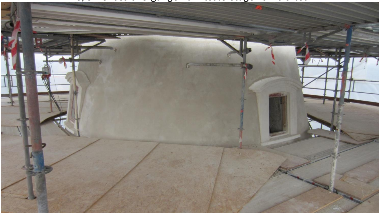
Allerede d. 18/8 var denne etage( Lorrisloftet) finpudset helt færdigt
