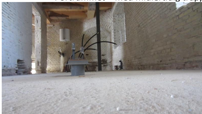
Herover skal håndværkerne i gang med at mure skillevægge og etablere Cafekøkken/Toilet
