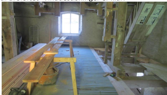
På Broloftet var man i gang med at lægge gulv først på ugen
