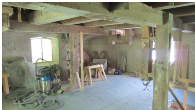
Nu er gulvet lagt færdigt – beskyttet under pap
