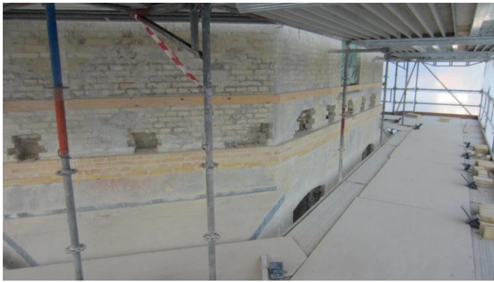
Først på ugen blev man klar med de 32 huller til i Svikstillingens støttestolpebeslag nederst
