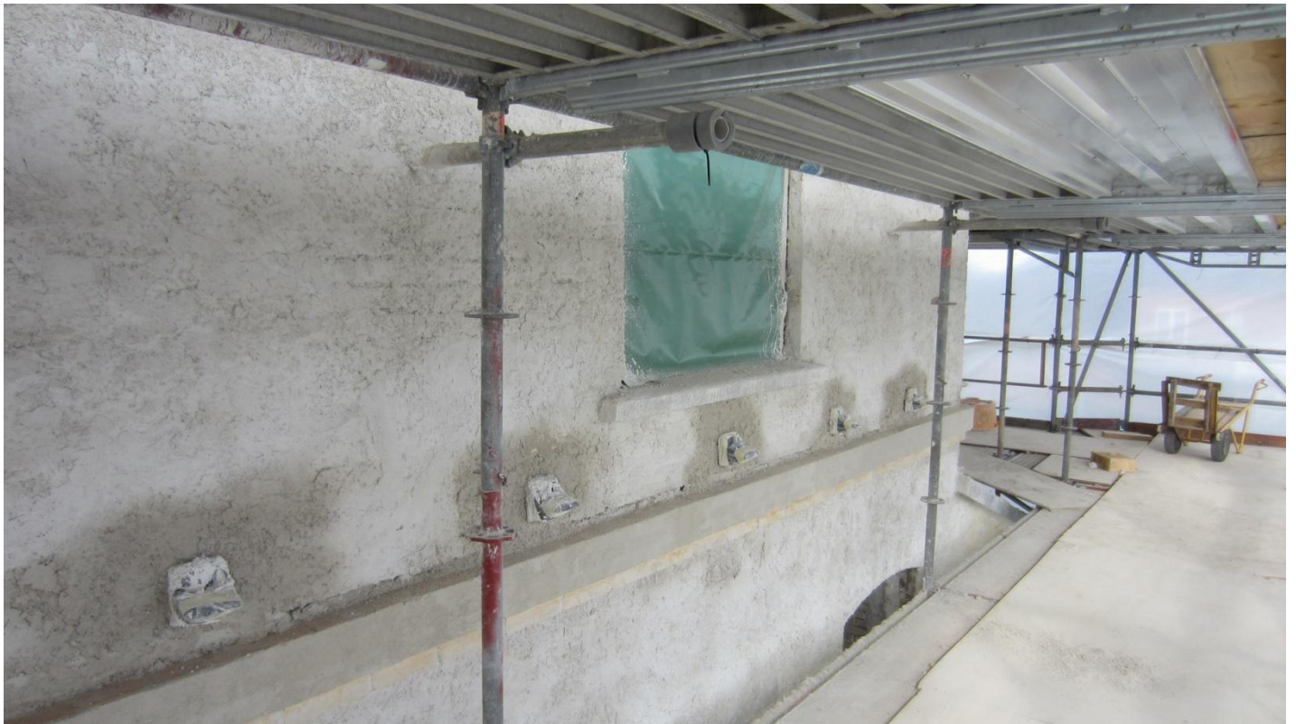
På den allernederste del, Broloftet lige over Portrummet mangler der at kun at blive finpudset udv. Men cementen rundt om beslagene skal også lige tørre helt op.
