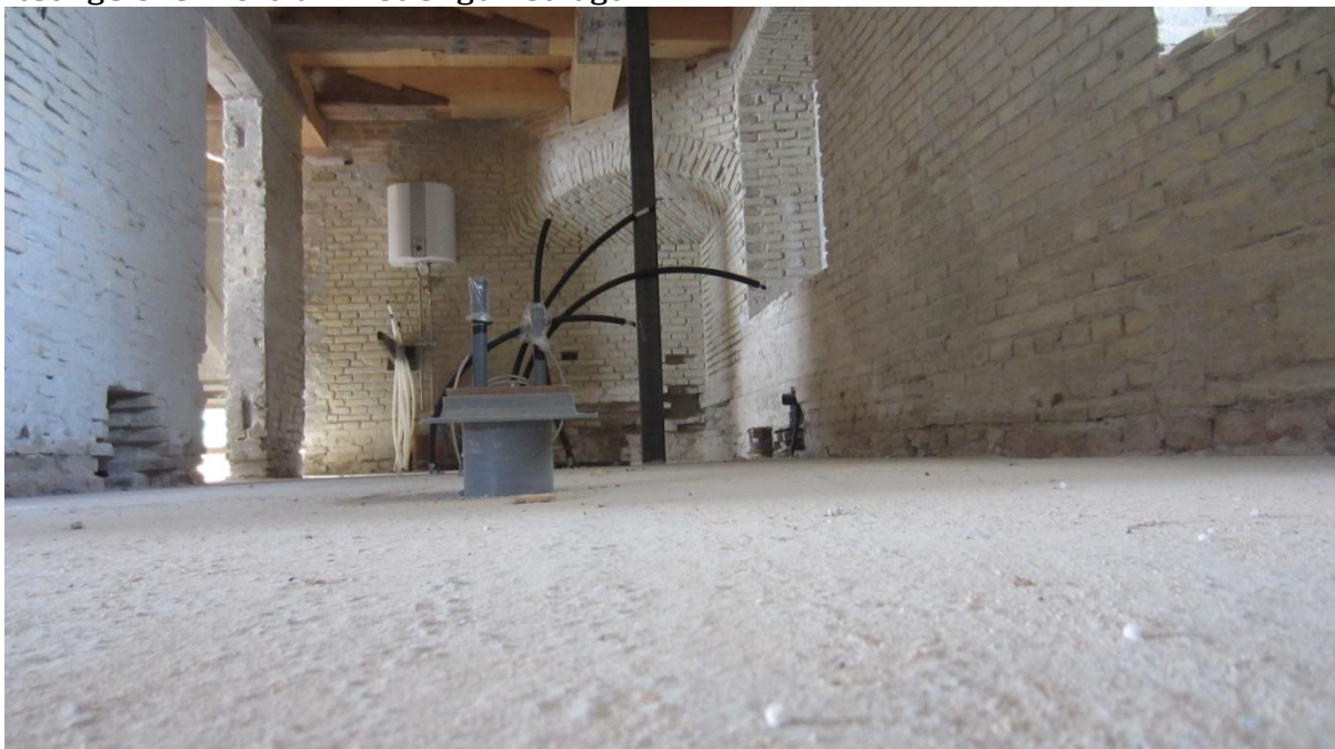
I hele Portrummet er der blevet lagt et tykt støbelag med Gulvvarme - Bemærk de mange hvide slanger bagerst. I den ene side af Portrummet deles dette rum (herover) op i et Cafekøkken og et toilet som også er Handicapvenligt.
