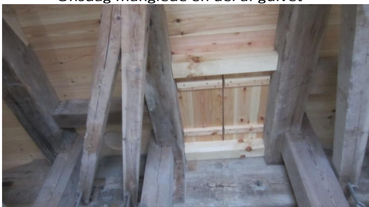
Gulvet på Kværnloftet med lemmer er færdig
