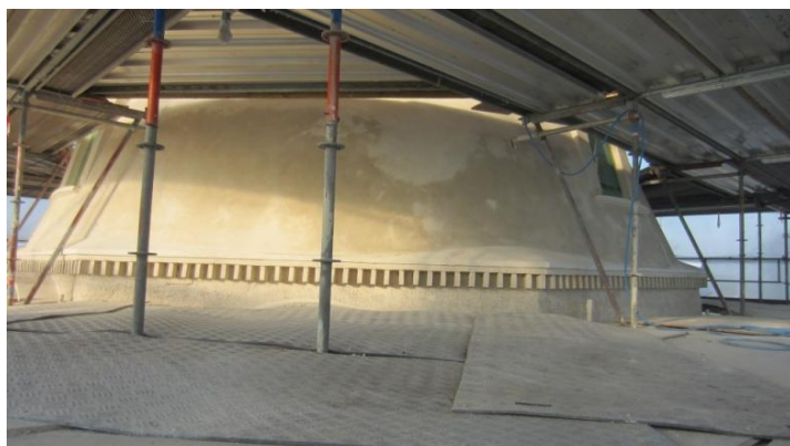
Hele overmøllen er finpudset og klar til maling
