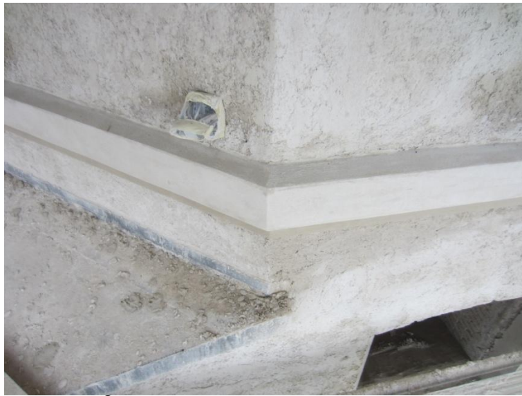
Murere har brugt dagen på at pudse den nye kant lige under stolpebeslagernes støttepunkt.
