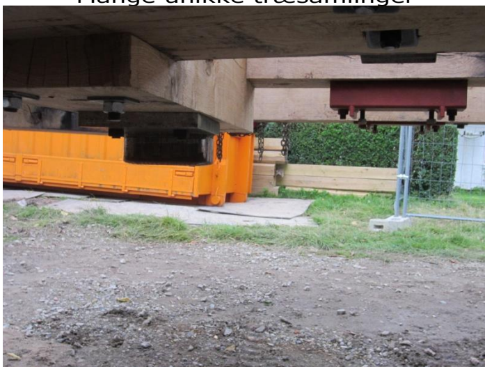
Under hatten er glidebeslag monteret
