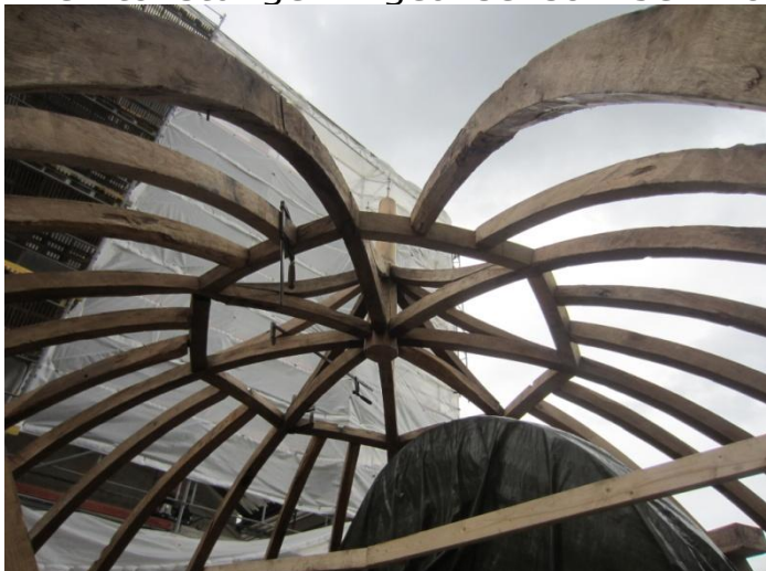
Bemærk møllehattens opbygning
