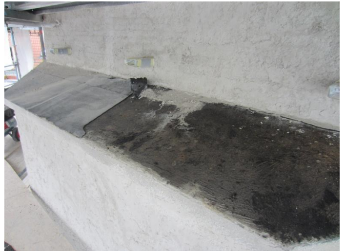
Skal lige hærde op inden finpudsningen. Det gamle lag af tjærepap skiftes ud
