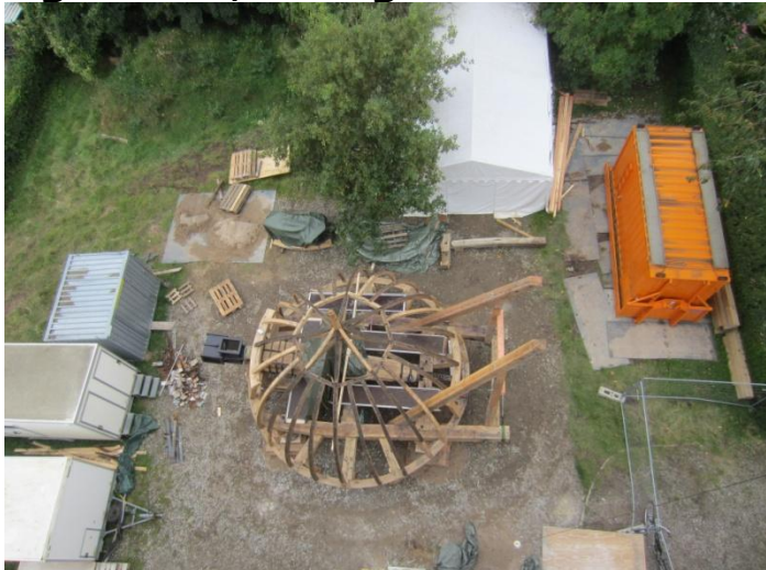
Møllebyggeren har fået leveret deres grej og arbejdspladsen er indrettet.
