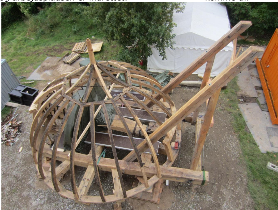
Siden i går er der udover indretningen allerede samlet den løgformede overdel
