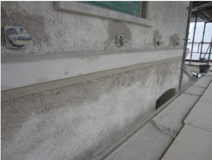
Skal lige hærde op inden finpudsningen. Det gamle lag af tjærepap skiftes ud
