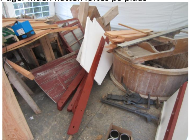
Klapperne er 1 cm tykt træ og tømmeret er 3x3
