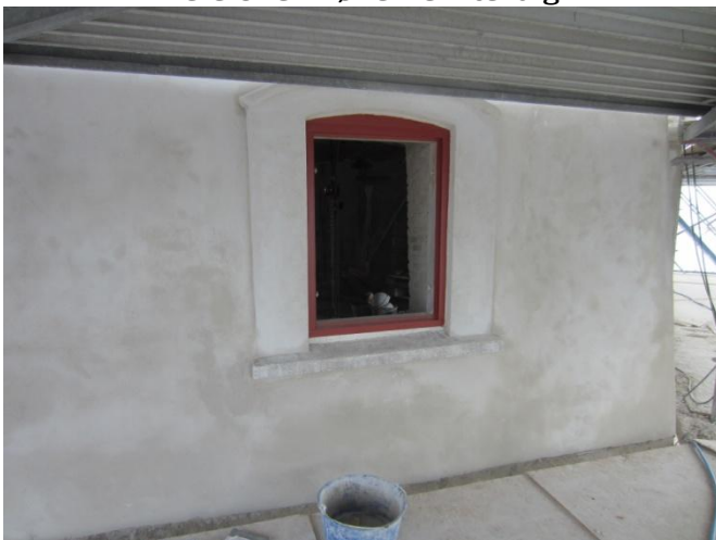
På Kværnloftet er nu pudset og klar til maling
