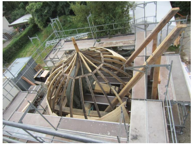
Stillaes er monteret for at lette arbejdet
