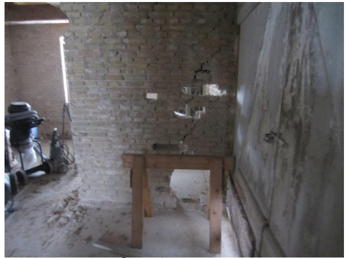
Murværket gæses efter – Sten pilles ud og udskiftes
