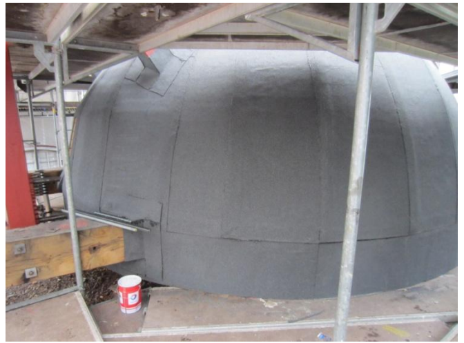
Bemærk det kraftige tømmer som skal holde vindrosen
