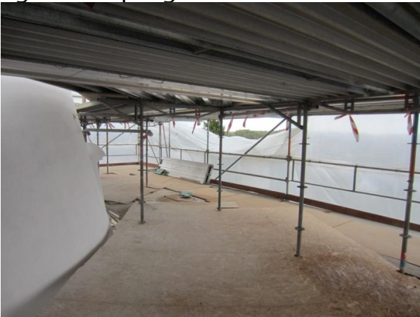
Der er blevet revet nogle huller af vinden især på de øverste etager
