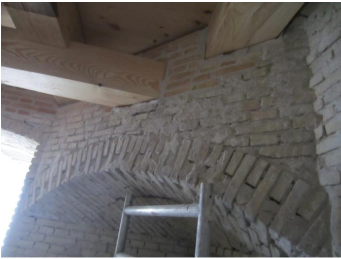
Inde i Portrummet er man i gang med mur-reparationer – de gule sten øverst
