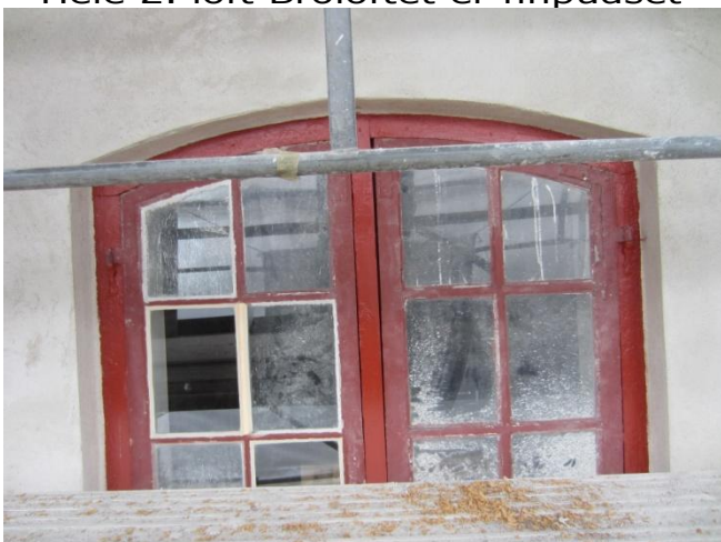
Vinduer er sat i, træ, glas er skiftet ud
