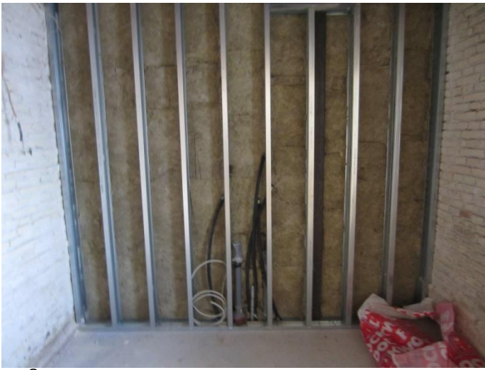
På køkkensiden i gang med isolering.
