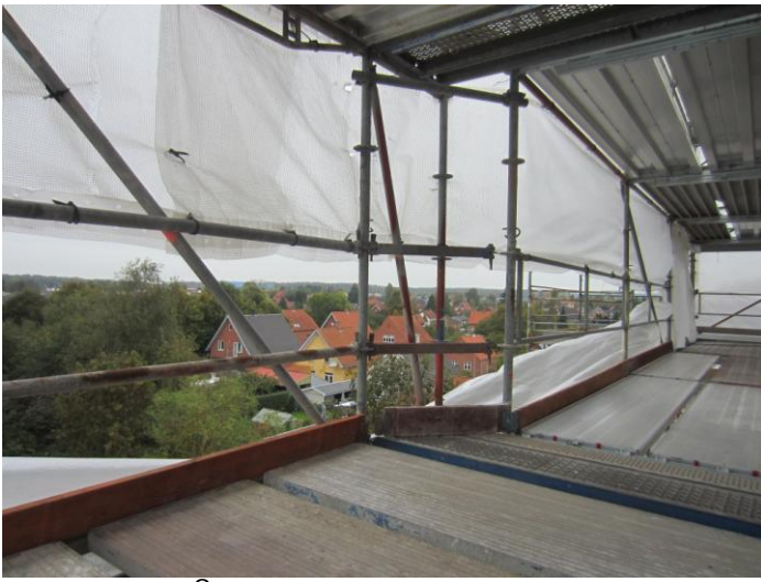
Arbejdet på de øverste etager er færdigt
