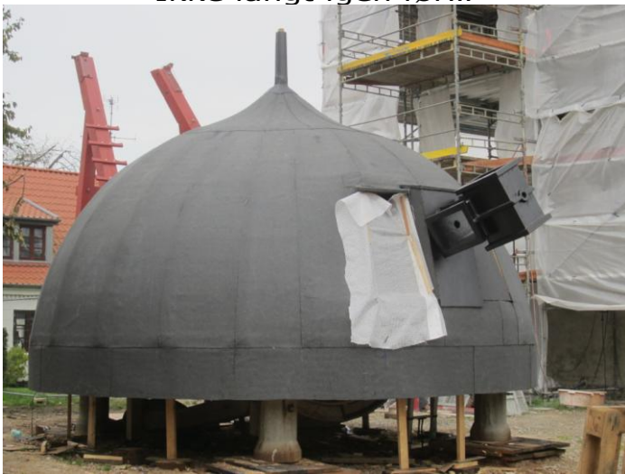
Hatten kan blive løftet på plads!
