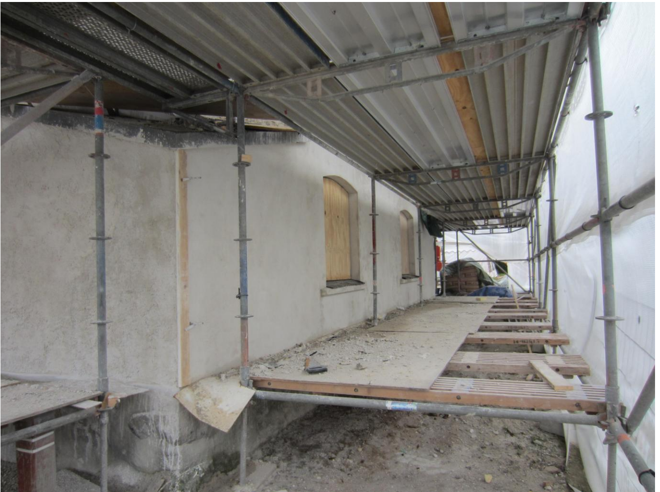
Uden på Portrummet er vinduerne pakket til og den sidste finpudsning i gang
