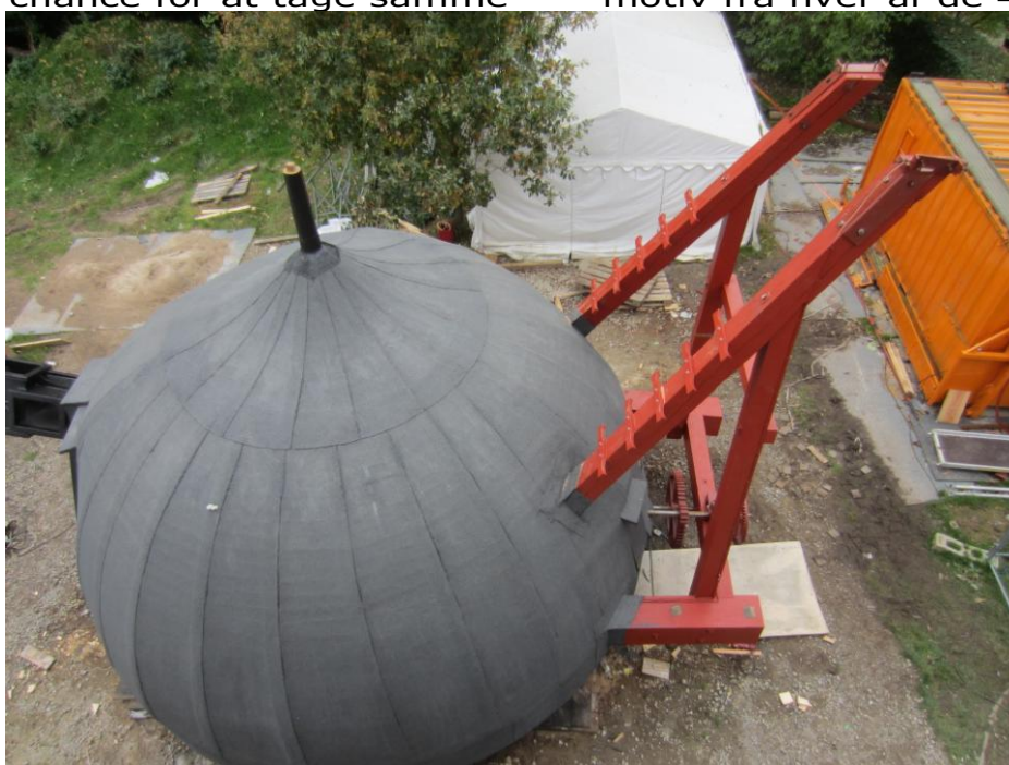
Hatten mangler kun kuglen øverst og vindrosen – bemærk trinnene op til vindrosen og det flotte tagpararbejde
