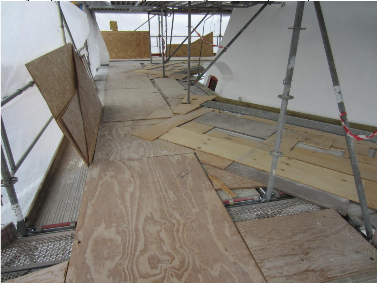
Man er nået til tredje øverste dæk hvor der stadig ligger plader
