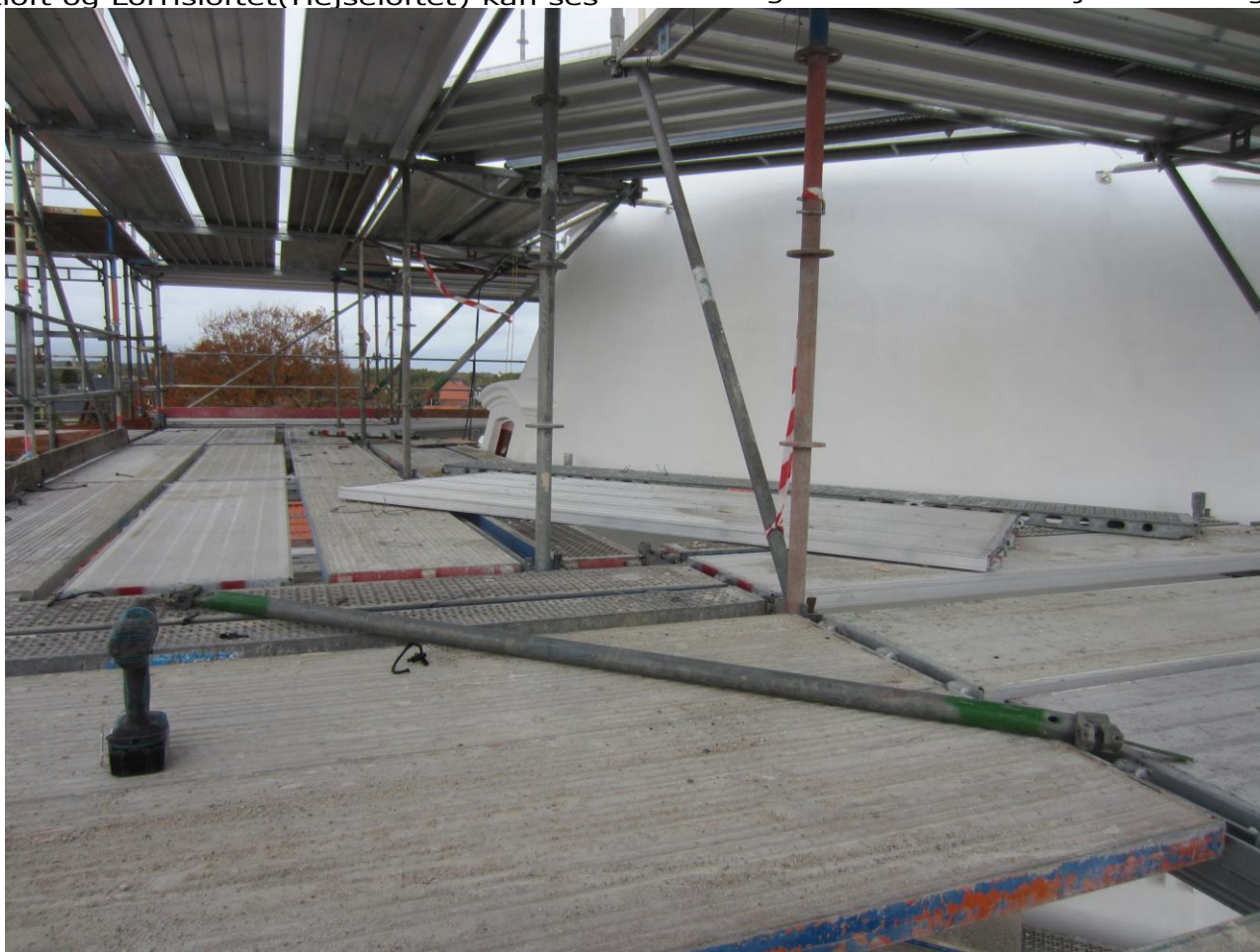
De næste tre dæk nedad har fået afmonteret alle træplader – klar til nedtagning
