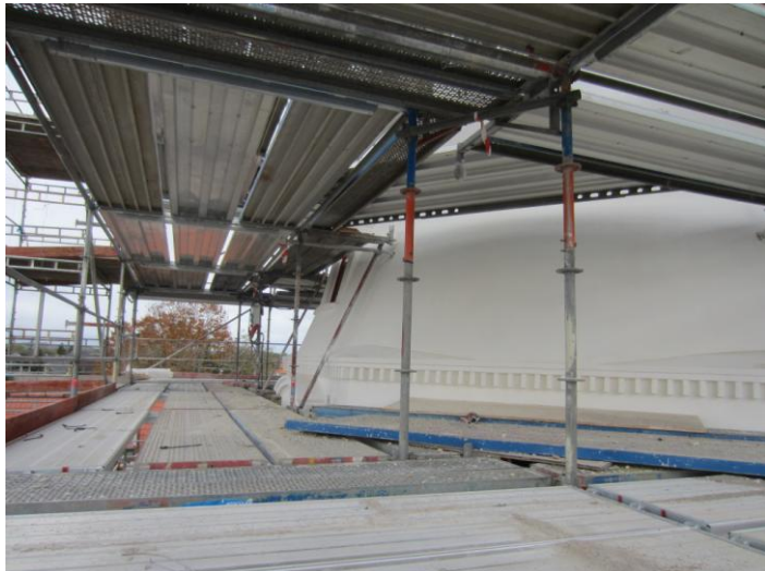
De næste tre dæk nedad har fået afmonteret alle træplader – klar til nedtagning
