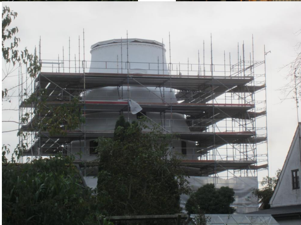
Hele det øverste dæks overdækning/tag er nu pillet ned
