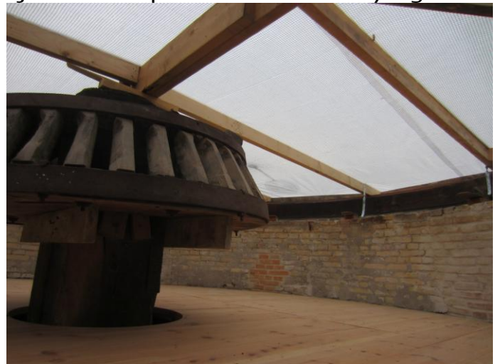
Øverst oppe Hatloftet hvor hatten sænkes ned på Krøjekransen
