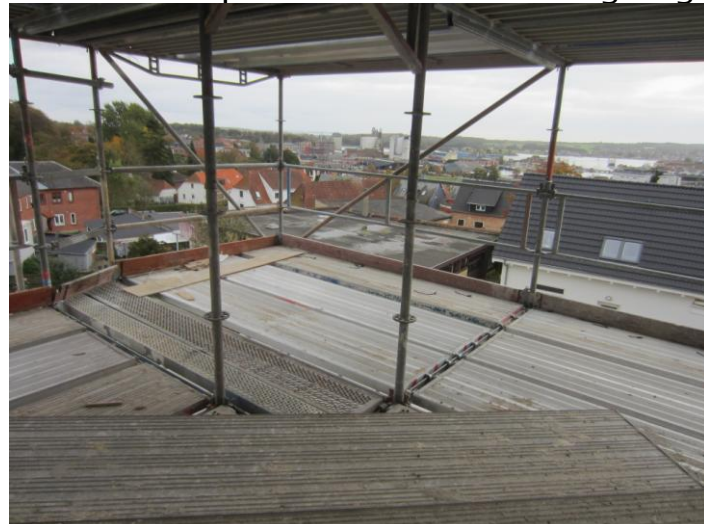
De næste tre dæk nedad har fået afmonteret alle træplader – klar til nedtagning
