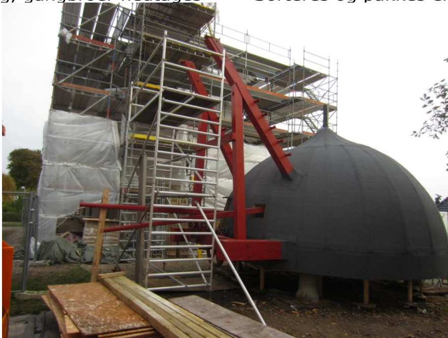
Imens knokler møllebyggerne med at få de sidste ting på plads
