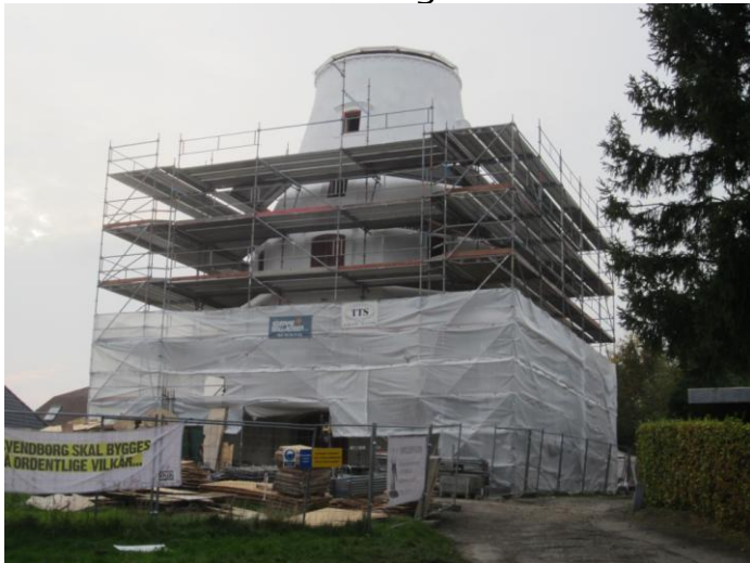
Alle rør, beslag, gangbroer nedtages
