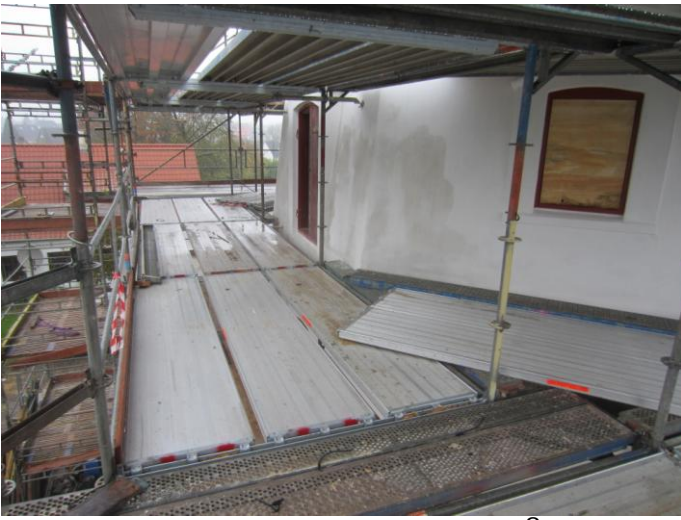
Dette loft og bund skal også væk her skal bygges svikstilling
