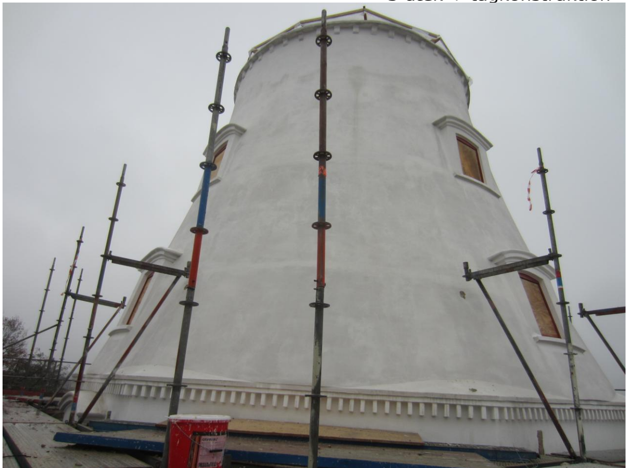
Alle fæstningspunkterne på møllen reparerer, puds og males
