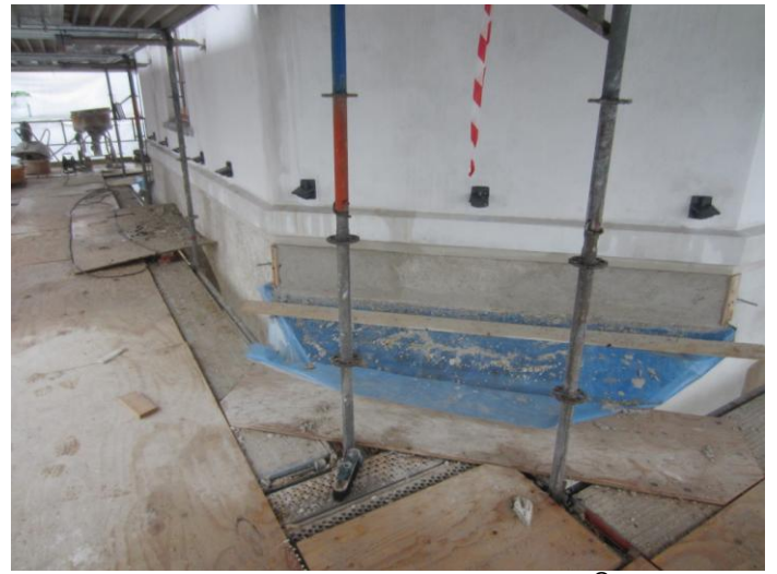
Etagen under, med plader på, skal bruges når svikstillingen skal laves
