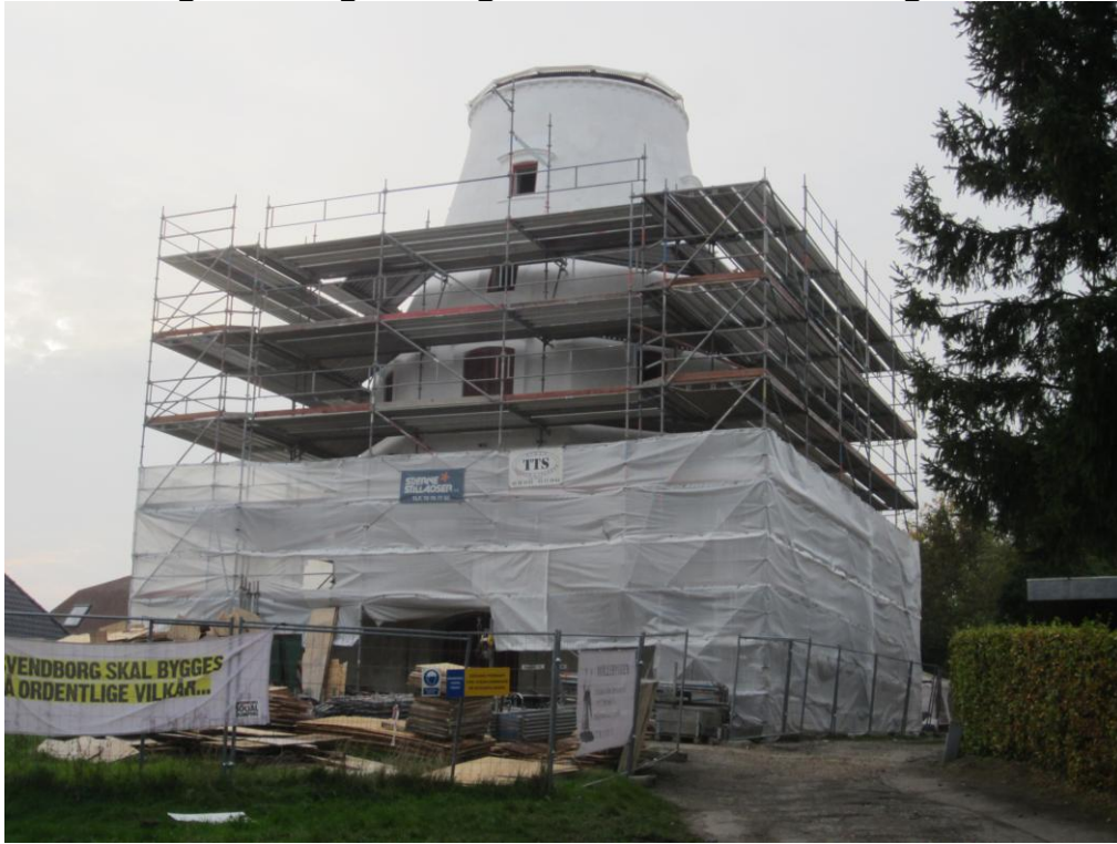
Da torsdag sluttede var stilladsarbejderne to dæk + taget
