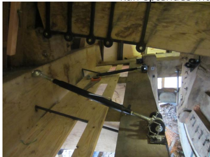
Her ses de to orkansikringer - taget fra I baggrunden ses et af de otte beslag på vingehjulet som kan låses i.
