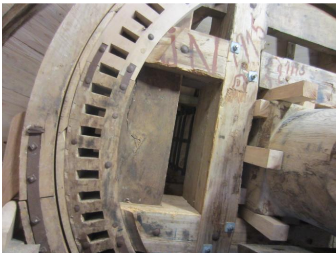
Det store Hathjul med en diameter omkring 2,5 meter
