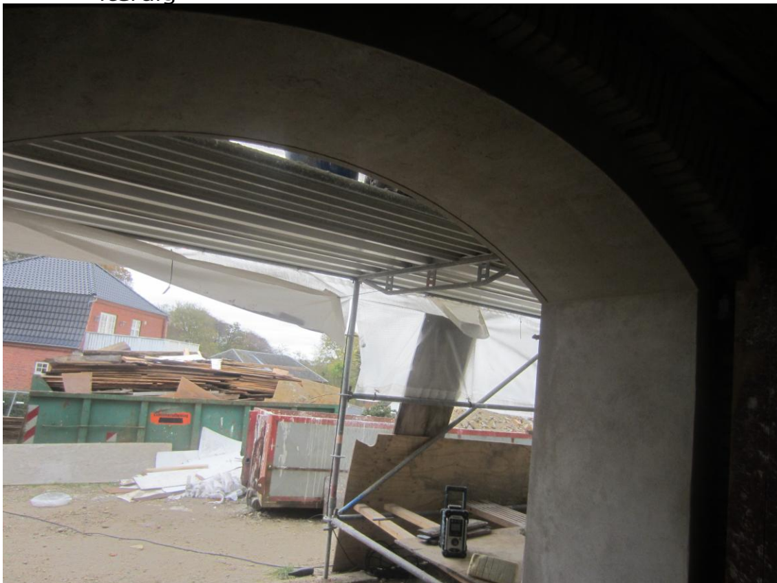
Portene flyttes ud og flugter med bygningen – indvendigt kommer Glasdøre
