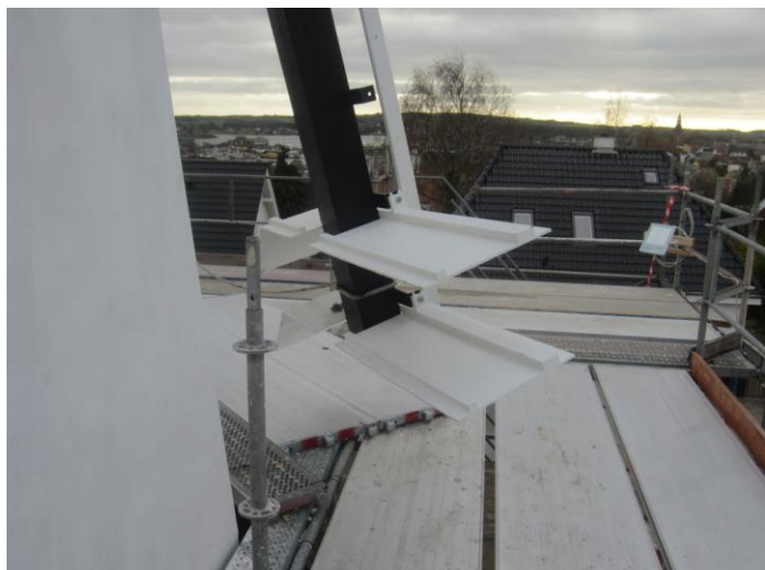
Herefter knappes Styreskinnen på disse
