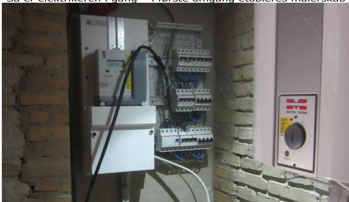
Så er elektrikereren i gang – i første omgang etableres målerskab
