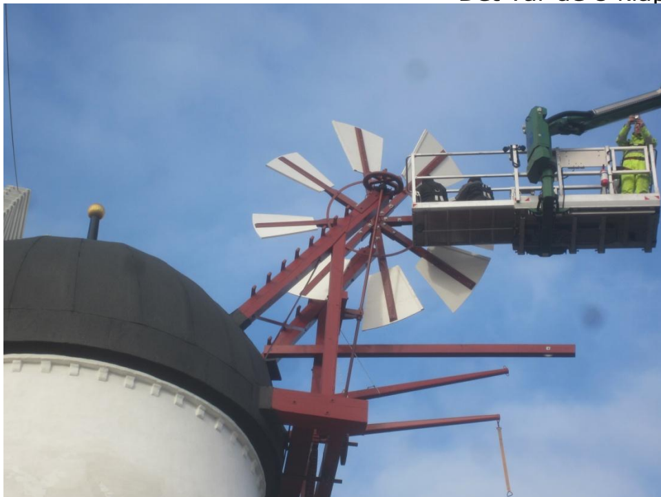
Den runde tynde ring boltes fast i de 8 vingearme
