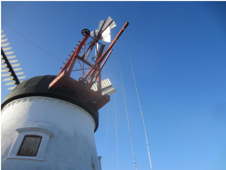
De to x Wire t.h. styrer åbne/lukke for klapperne- Den sidste Wire er Bremsen
