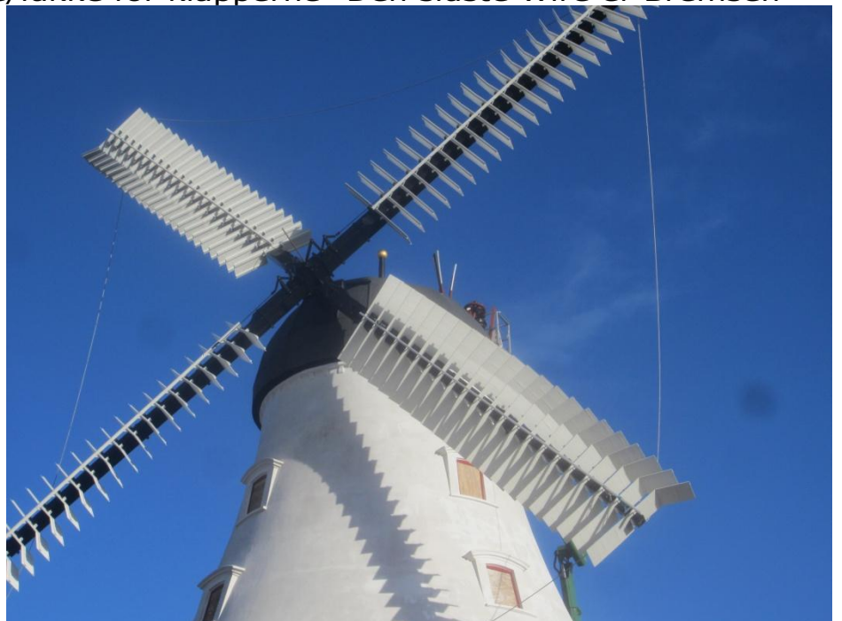
Snoren mellem vingerne sikrer at de ikke drejer rundt og at klapperne ikke lukker i.
