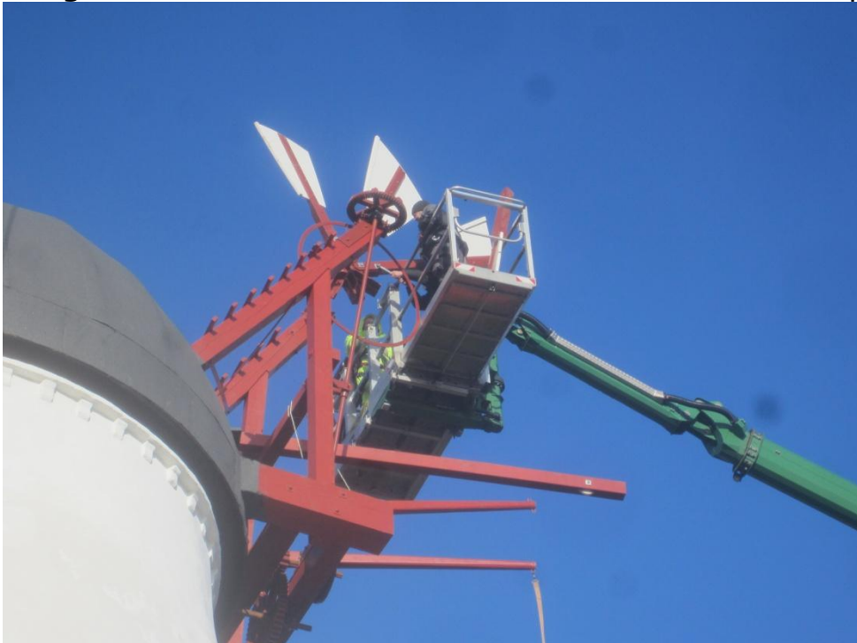
Den 3. klap på vindrosen spændes fast
