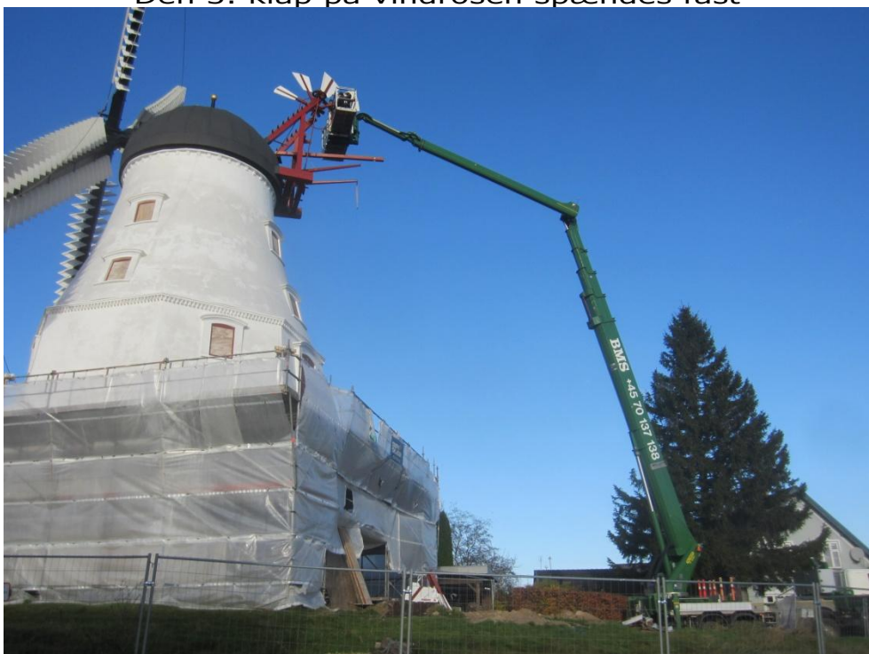
Den 3. klap på vindrosen spændes fast
