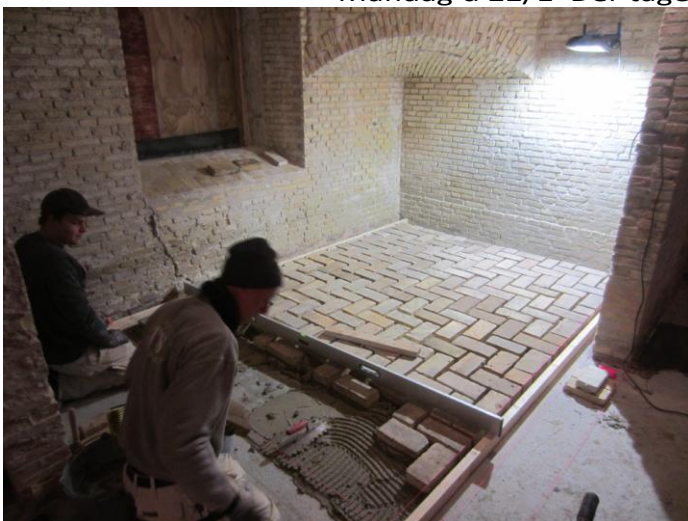
Uge 4 Så er de to murere fra TTS i gang
