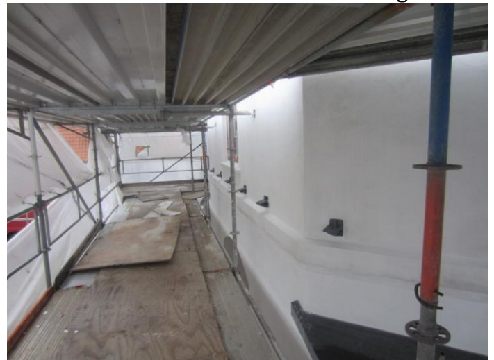
Dele af stillads skal fjernes inden skråstiverne kan monteres og boltet på.
