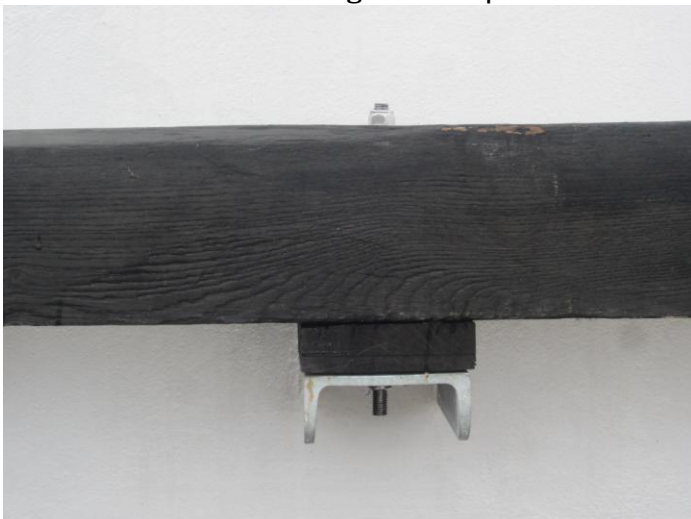
Der bores for og det svære tømmer fastsboltet
