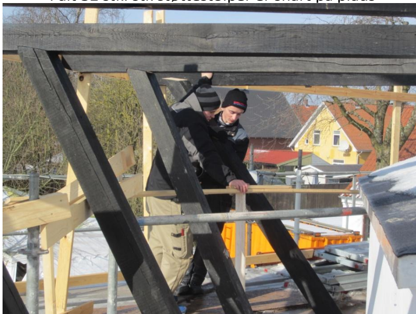
Hver støttestolpe vejer alene 80 kg. X 32 = 2,5 ton Det samme vejer de vandrette - så 5 tons skelet stilles op
