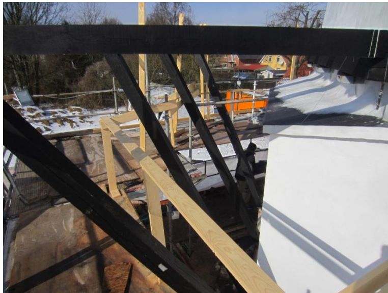
I alt 32 stk. stk støttestolper er snart på plads
