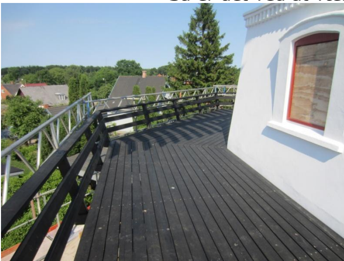
Isætning af nye vinduer
