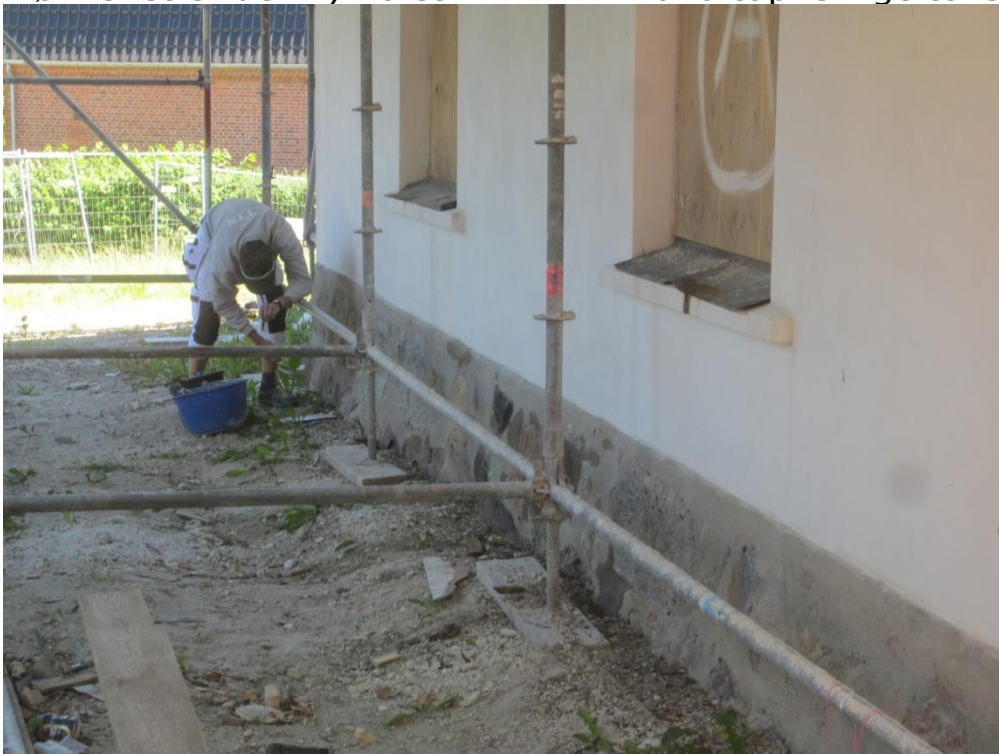
Murerne fra TTS er ved at lave finish på soklen
