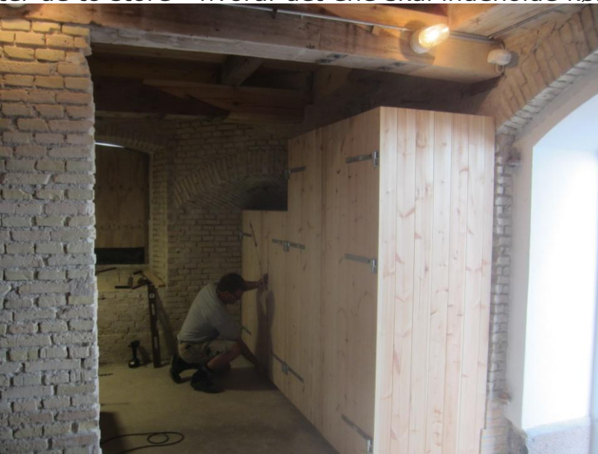
Igen tilpasning isætning af hylder. Hjemme på værkstedet tørrer bordpladen op og sættes op i morgen.
