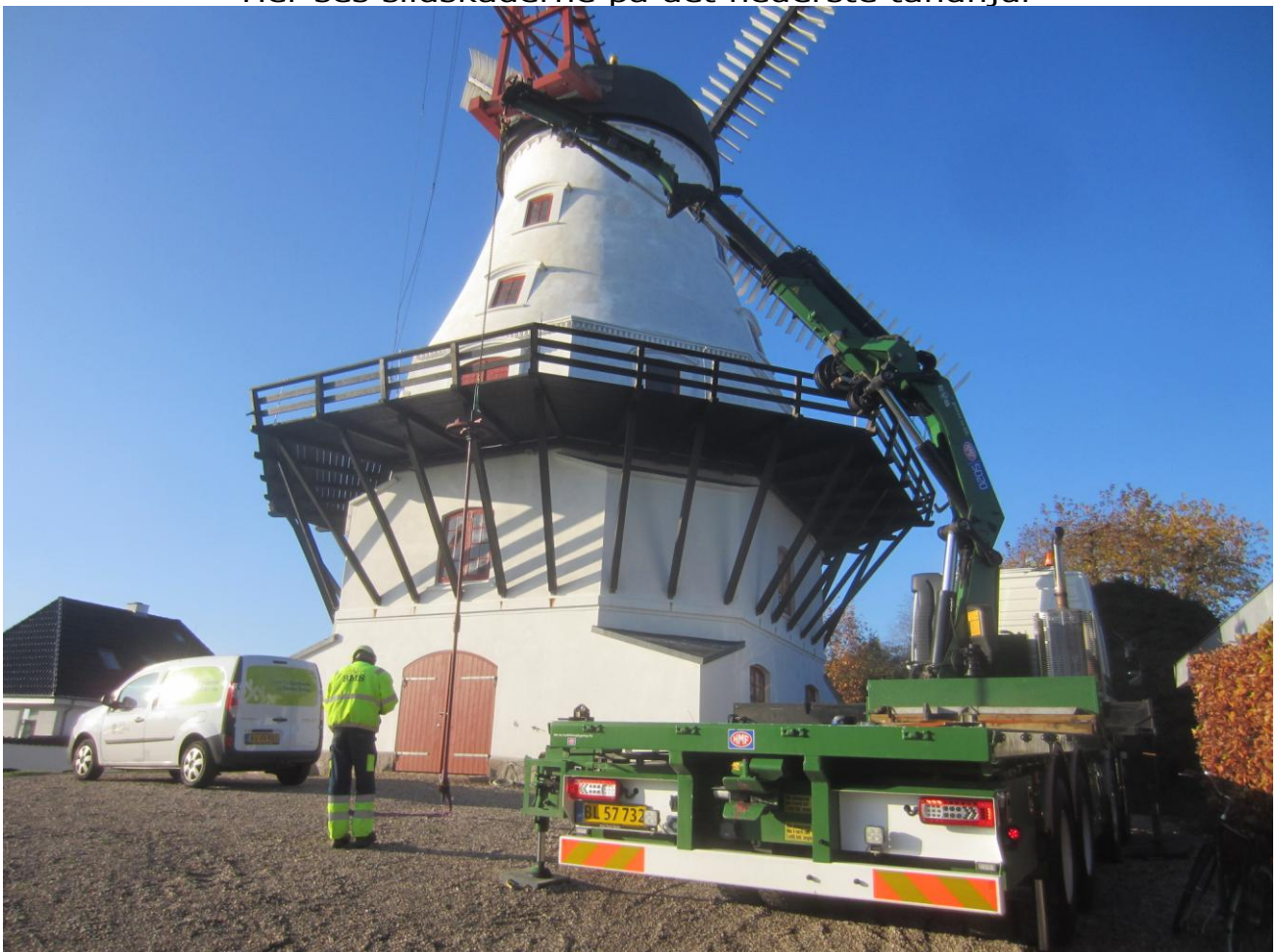
Den lange aksel læsses på Møllebyggerens bil og de kører til Sjælland. Om en uge vender de tilbage hejser den reparerede Krøjestang på plads igen
