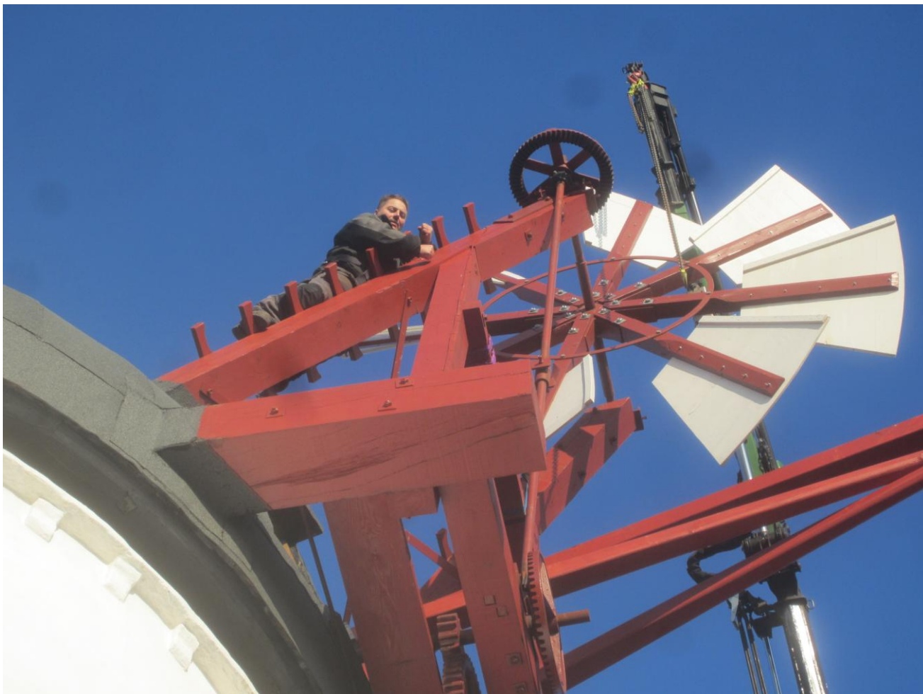
Møllebyggeren iført sikkerhedsline kravler ud og afmonterer beslaget
