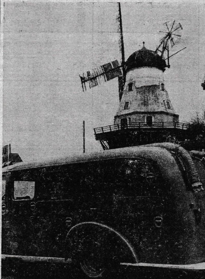
Christiansmøllen, der er Svendborgs vartegn, fik vingerne og den elektriske installation ødelagt under gårsdagens voldsomme orkan, der i eftermiddags-timerne også var hård ved mange hustage på det øvrige Sydfyn, Tåsinge og Langeland.
