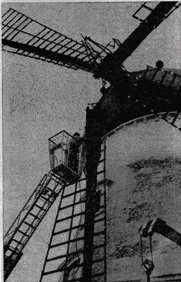
Det ene sæt mølevinger blev pillet ned efter stormen i januar, og nu skal også de sidste to mølevinger afmonteres og udskiftes.
