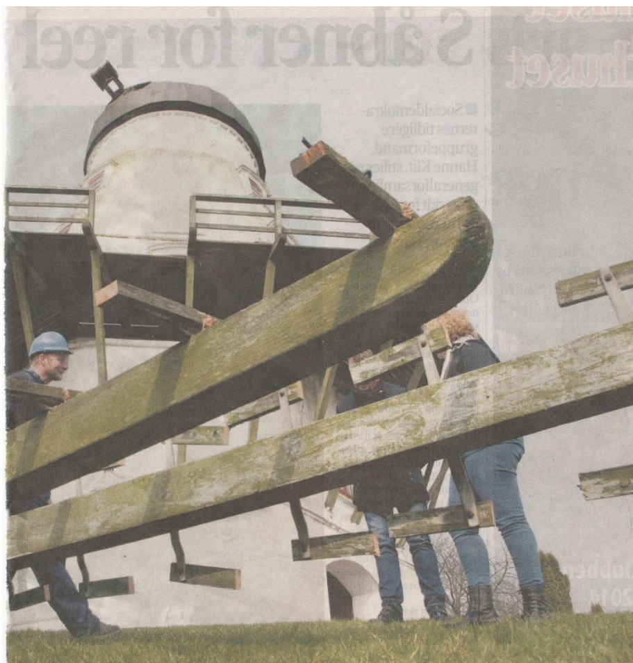
De to vinger vejer hver knap et ton og måler 21,8 meter. Nye vinger til vindmøller kan kun laves af douglasgraner. Det er de eneste træer, der er høje nok.
