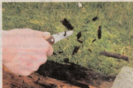
Vingerne er angrebet af svamp og råd. Det samme er vindbjørnen i hatten, hvor navet sidder fast.
