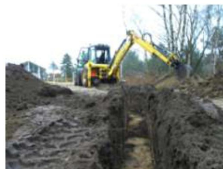
Gravearbejdet er godt i gang ved Grubbemøllen
