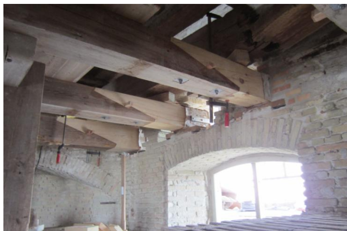
3 bjælker hvoraf den ene er muret til og de to sidste er ved at være klar.
