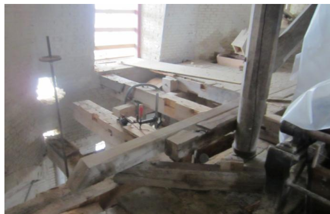
Vi er på kværnloftet. Herover ses det nederste af kongevellen og de vanskelige arbejdsforhold er synliggjort.
