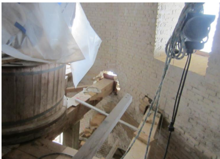
Vi er på kværnloftet. Herover ses det nederste af kongevellen og de vanskelige arbejdsforhold er synliggjort.
