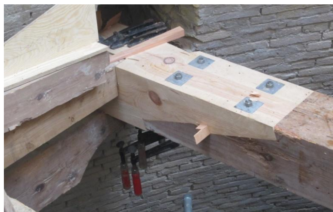
Bemærk at enderne inden der mures til fra begge sider sættes et jern i og beklædes med kraftig Birkebark. Et gammelt håndværk som stadig udføres som man har gjort i rigtig mange år
