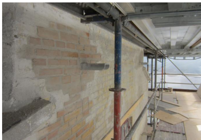
I Væggen sættes bundjern til stolperne der skal bære Svikstillingen/omgangen
