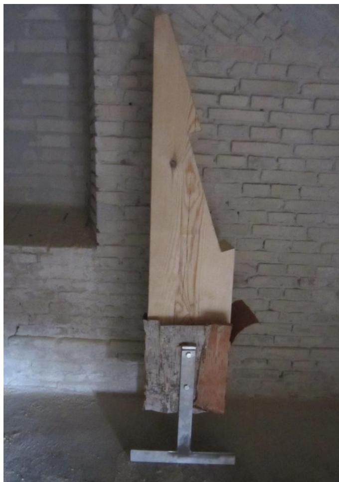
En færdig "Fransk lus" klar til at blive sat i.
