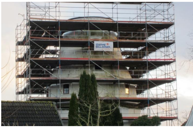
Stilladset på plads til op over hatten
