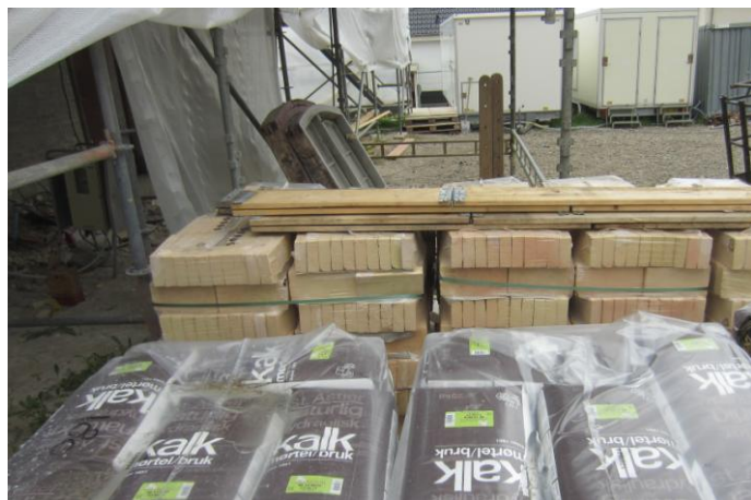
Masser af kalkmørtel og "Flensborgsten" som møllen er bygget af til reparationer.
