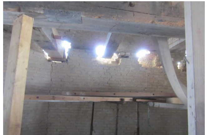
7. maj 2017 Håndværkerne er på vej nedad i overmøllen. Der fjernes gulvbrædder så man kan komme til.
