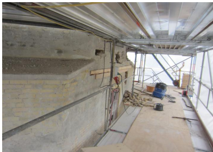
Her på 2. loft i undermøllen Broloftet er man også i gang. Igen er dele af gulvene fjernet så man kan komme til.
