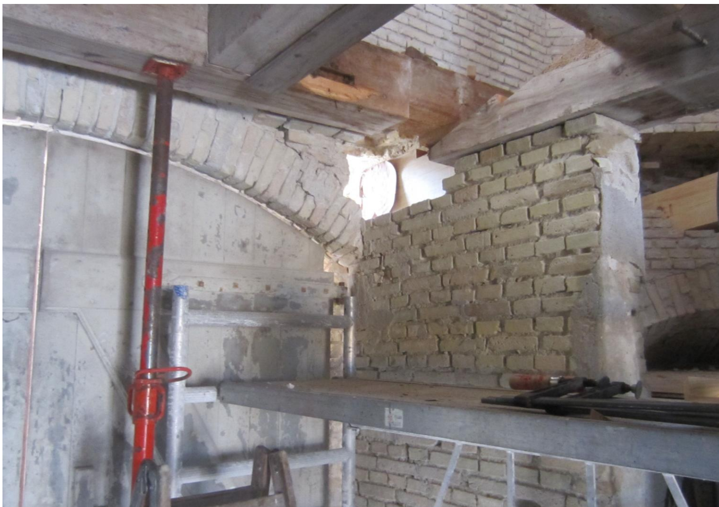
Også helt nede i Portrummet er man nu i gang med at udbedre det sidste murværk og skifte de bjælker der trænger
