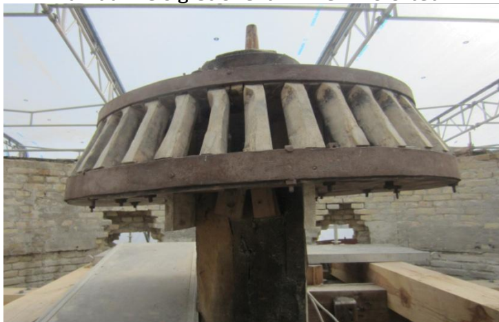
Man starter oppefra med renoveringen – helt oppe på hattoftet øverst i overmøllen. Møllebyggeren skal senere renovere selve hjulet som er meget slidt/ skævt
