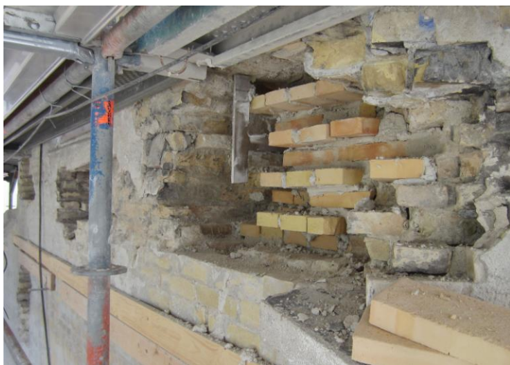
Her en større reparation af ydermur broloftet
