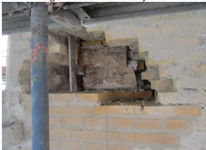
5. juni Der arbejdes stadig i undermøllen. Her enden af en bjælke med jern og birkebark på.
