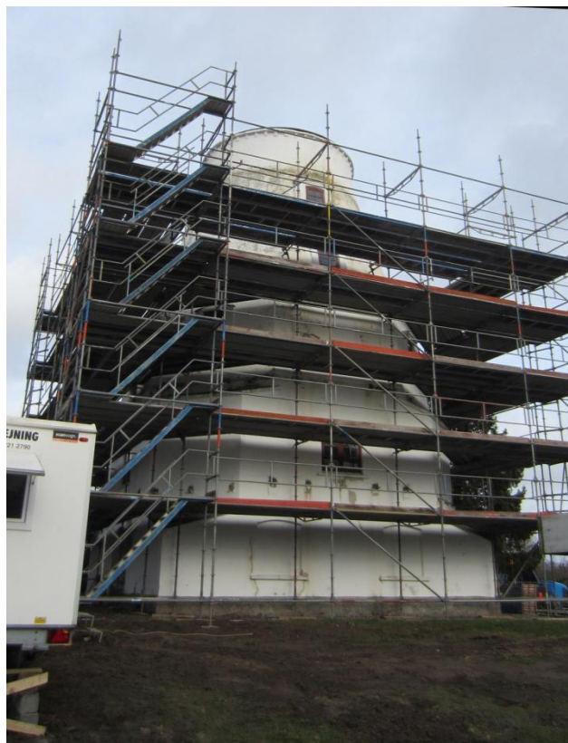
Herefter hegnes arbejdspladsen ind og indrettes med skurvogne, materialer, containere til affald m.m.
