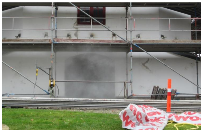
7. marts går sandblæsningen af alle mure udvendig som indvendig i gang
