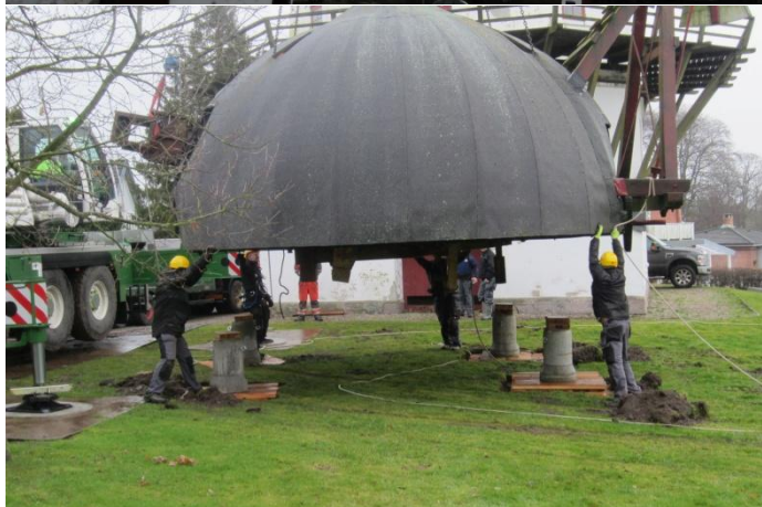
Kranfører og 4 mand til at guide den på plads
