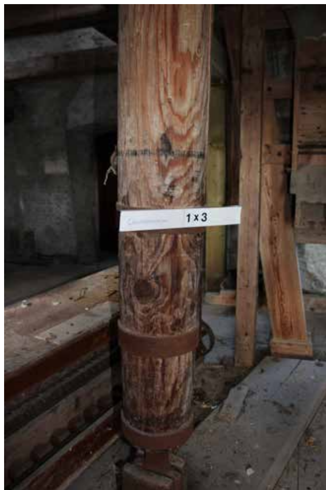
Drev til grubbe 1x3. Kværnloftet
