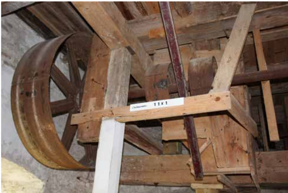
Transmissionsaksel - 11x1. Broloftet.
