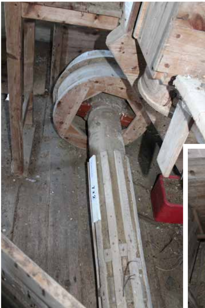
Hejs mod øst (bemærk ekstra hjul til fladrem) - 7x2. Hejseloftet.
