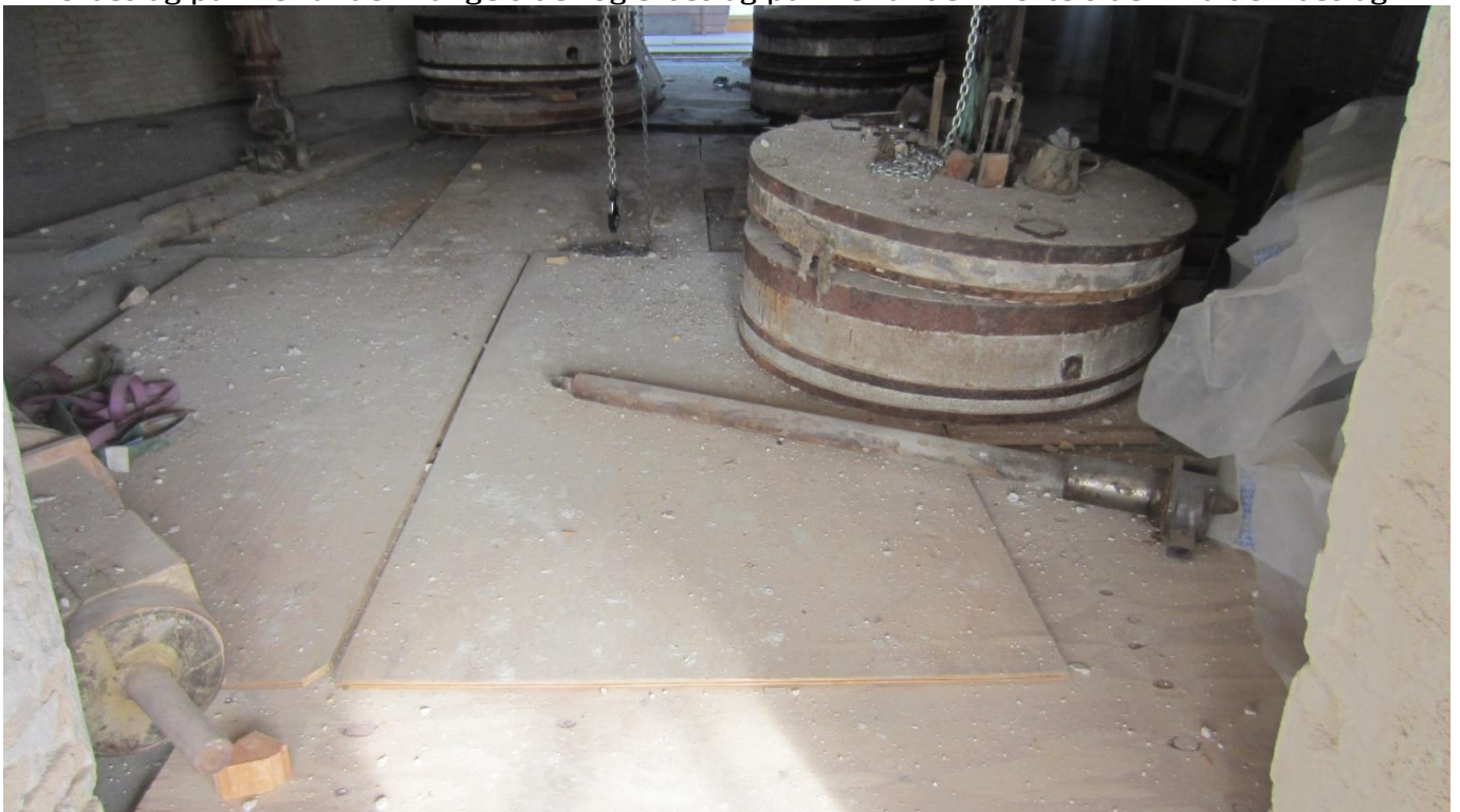
Indenfor i møllen er gulvene blevet repareret eller helt udskiftet Håndværkerne er færdige på de 4 øverst lofter – her kværnloftet hvor gulvet er nyt – Som det ses er de pakket godt ind med plader på så de ikke tager skade.
