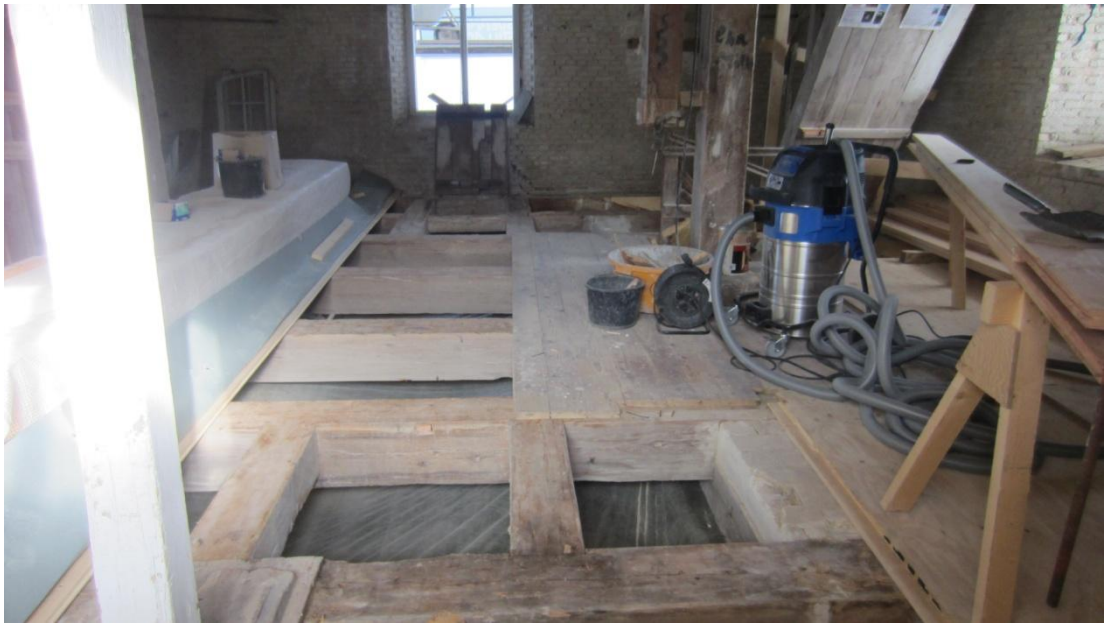
På Broloftet - det nederste loft før Portrummet er man godt i gang med at lave det sidste gulv.
