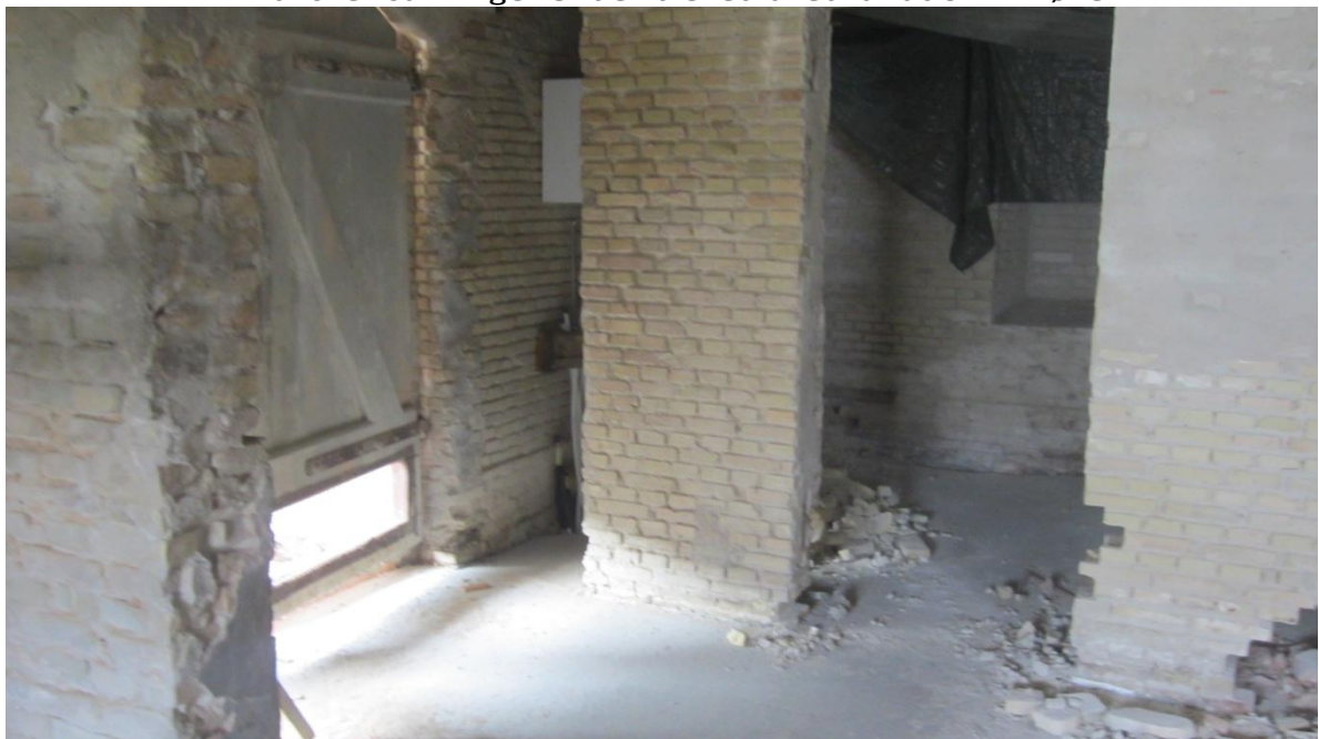
I portrummet er man nu begyndt på arbejdet med at skabe de to rum til et Toilet og et Cafekøkken Alle installationer med varmtvandsbeholder vand og kloak er forberedt.
