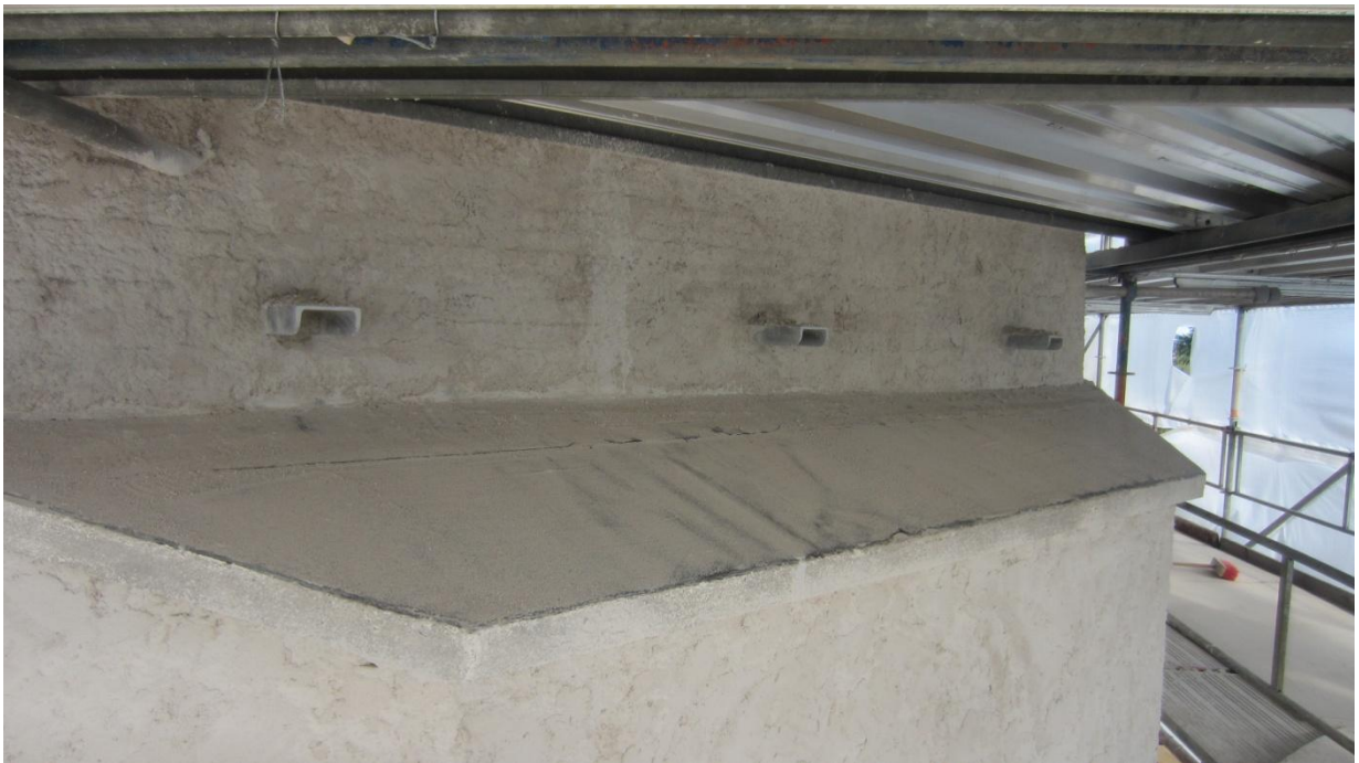
I bunden af kværnloftet er nu monteret de indmurede beslag som skal understøtte Svikstillingen
