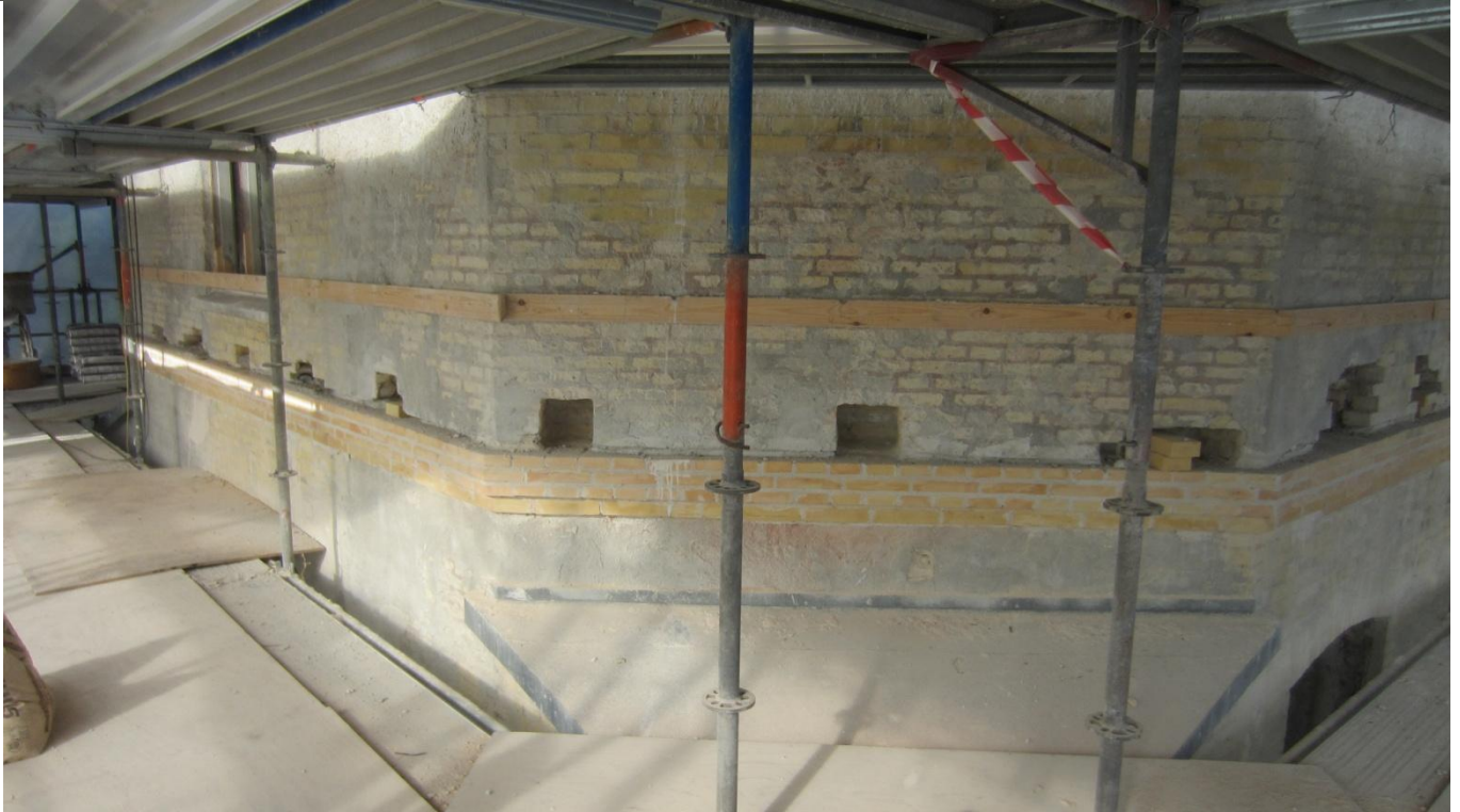
5 beslag på hver af de 4 lange sider og 3 beslag på hver af de 4 korte sider= i alt 32 beslag
