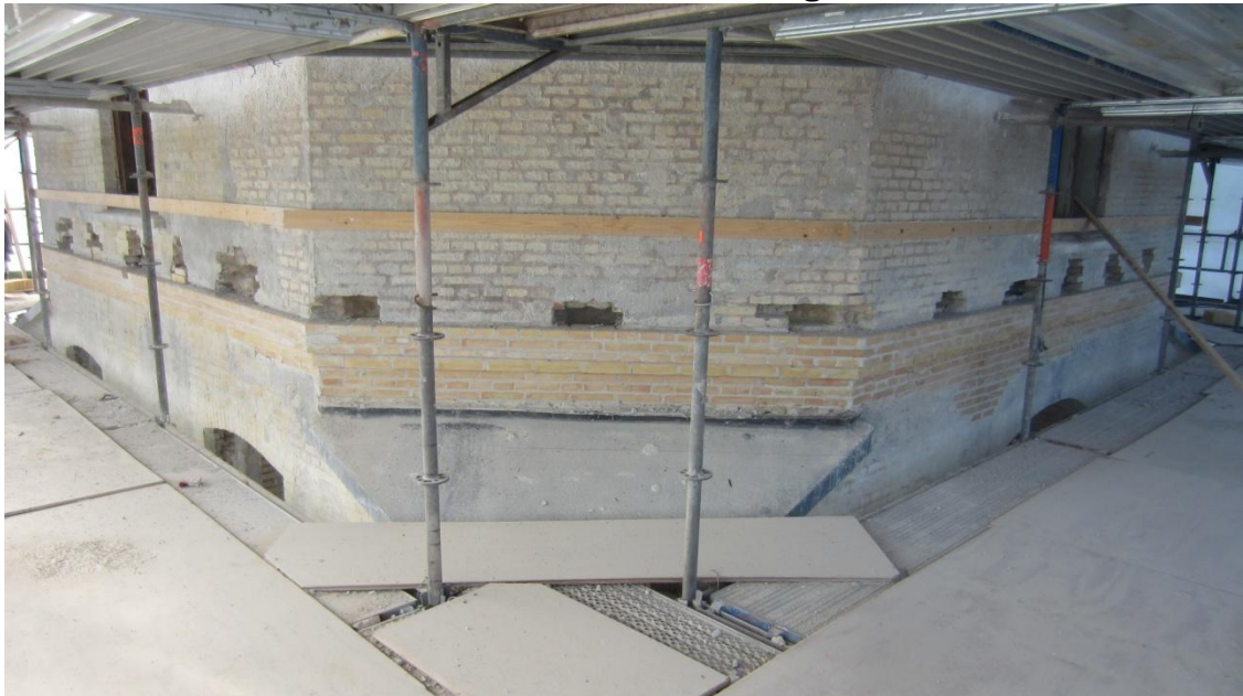
På Broloftet lige under er der pillet sten ud til de jernbeslag der skal holde støttestolperne
