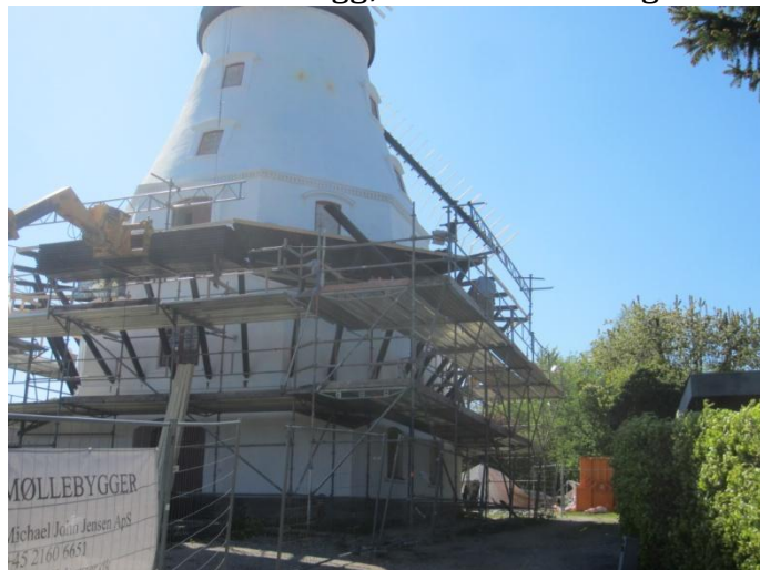
Der arbejdes nu på Svikstillingen samt isætning af vinduer og nye porte samt maling af disse.
