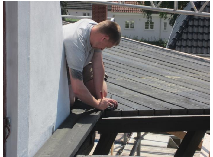
Den anden end skæres og den skrues fast.
