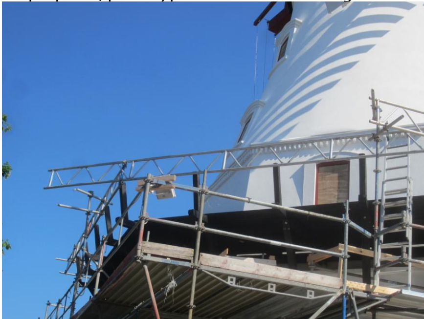
På et par timer er 10 ud af de 32 stolper nu sat fast med beslag
