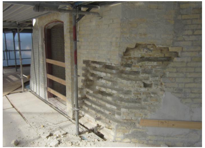
På Kværnloftet laaves de sidste murskader
