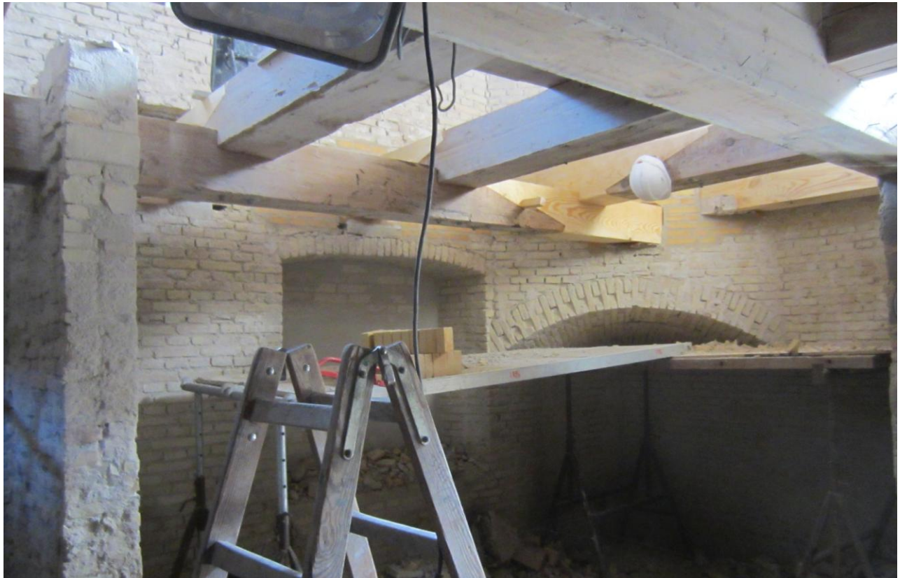
Sig nærmer tiden for at få sat de indtil nu tilmurede vinduer. De originale vinduer stod heldigvis i møllen
