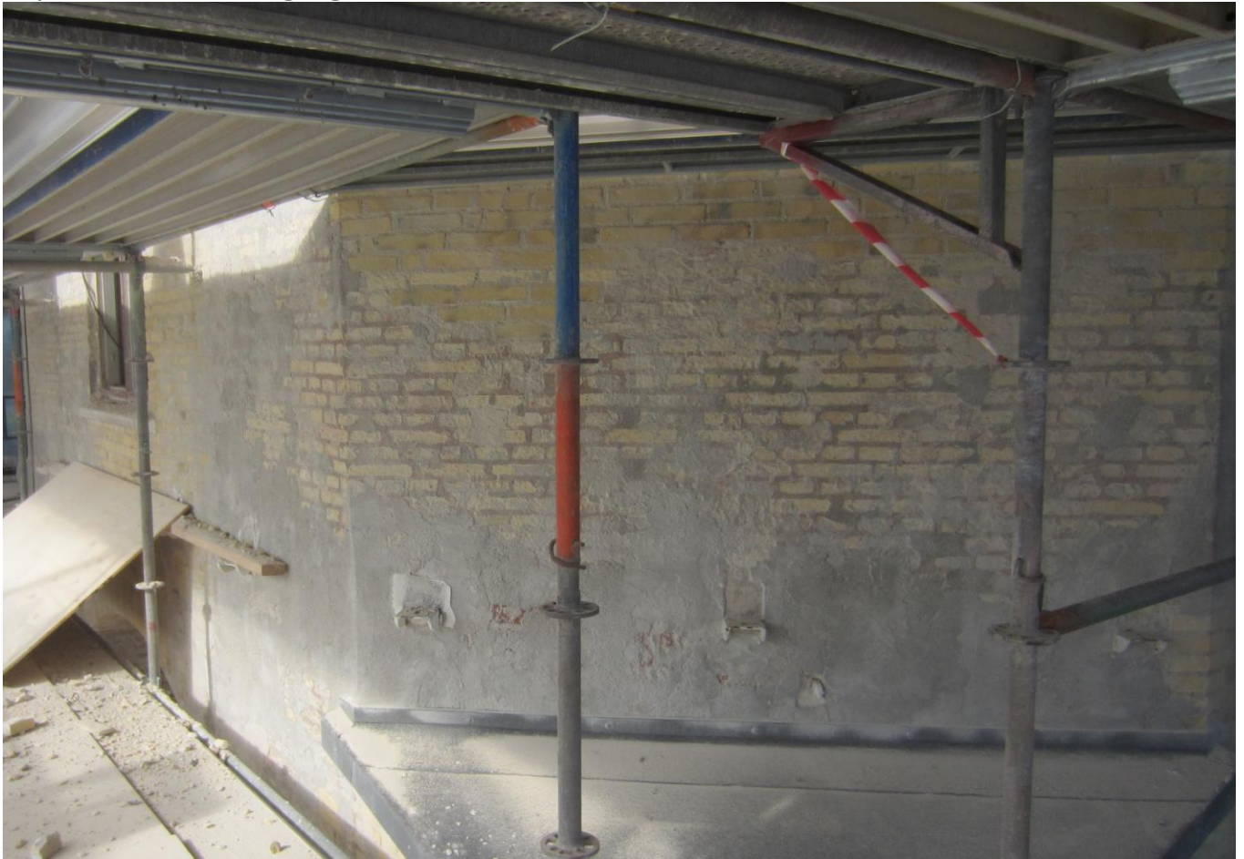
Under Kværnloftet med svikstillingen ligger Broloftet. Her mangler de sidste støttejern til stolperne der skal bære Svikstillingen
