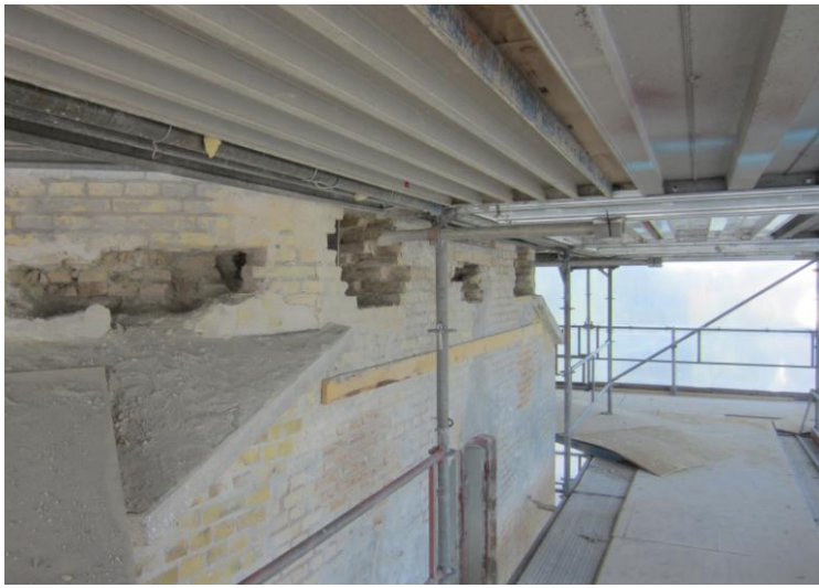
Broløftet hvor der arbejdes
