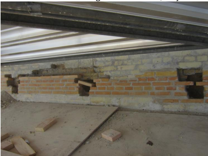
Og man er i gang med mur-reparationer
