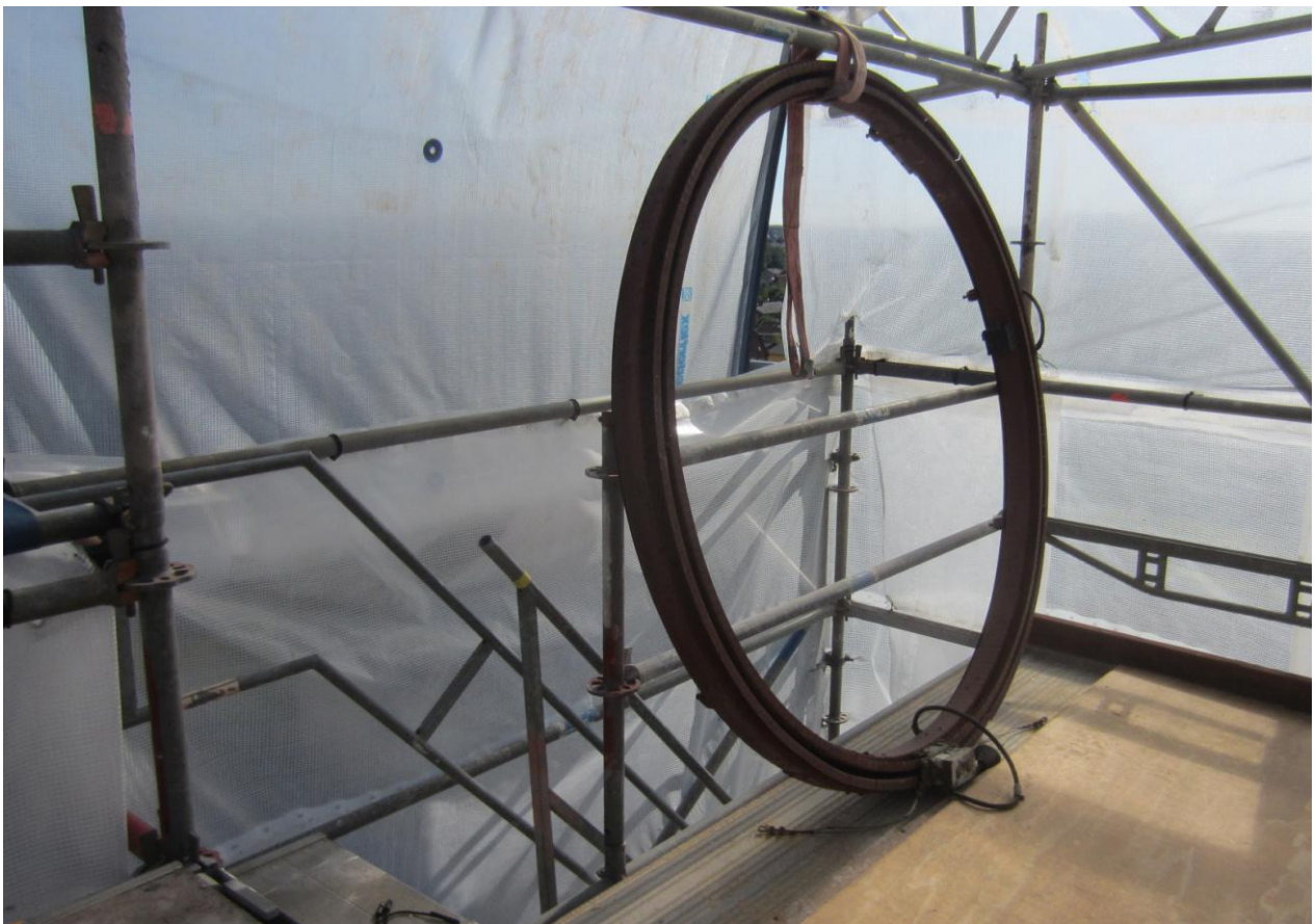
Møllefirmaet monterer bla. Krøjekrans/krøjering som hatten skal placeres på.
