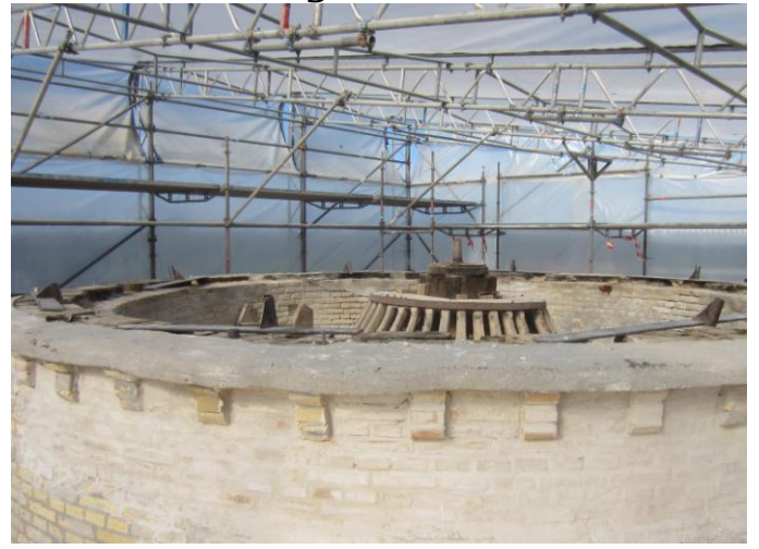
Uge 27-28 kommer Møllefirmaet restaurerer Hathjulet med forankring i Bjælkelag
