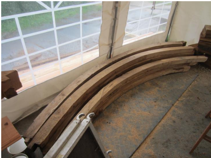
Indenfor i teltet ligger de indvendige krumme buer som skal skabe løgformen
