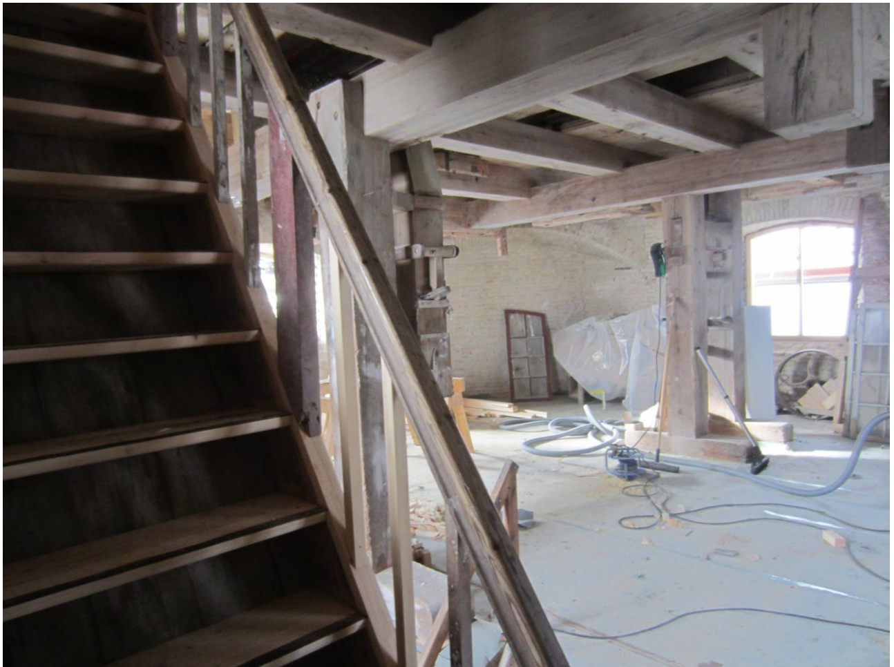
På Broloftet over Portrummet er den nye forstærkede trappe sat op
