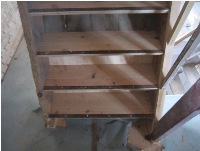
Helt nye trin med metalforstærkning
