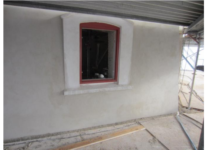
Finpudses der og efterfølgende males karme røde
